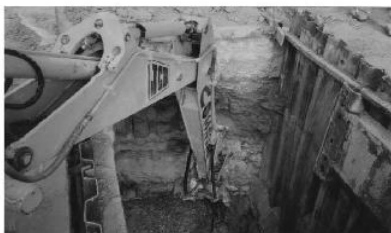
DEMOLICIÓN MECÁNICA EN ZANJA
