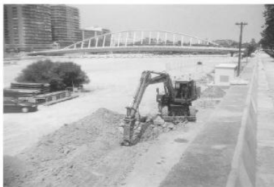
DEMOLICIÓN MECÁNICA A CIELO ABIERTO
