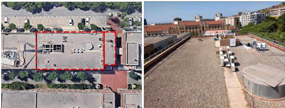
Vista aèria estat actual
