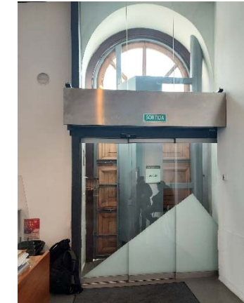
Portes entrada secundària
