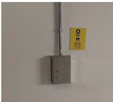
Figura 9 Intèrfon a sortida d'emergència
