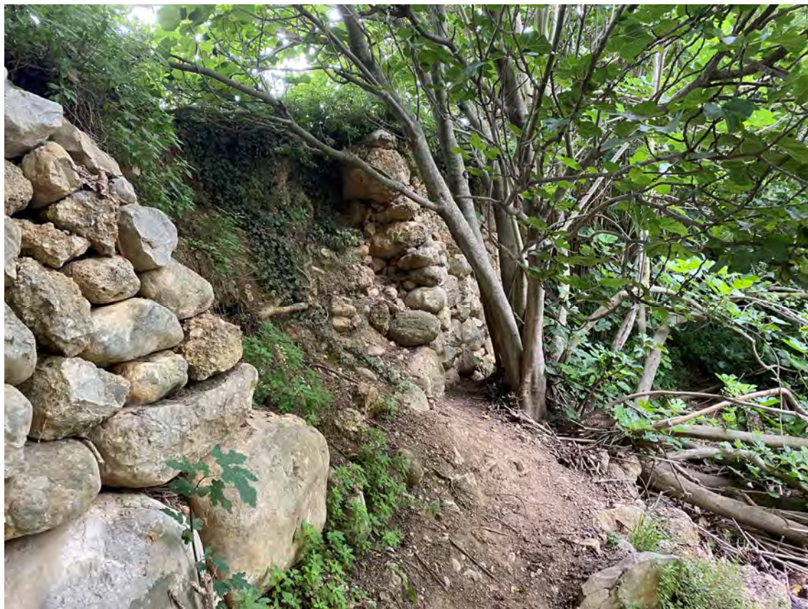
Imatge 15. Reconstrucció marge solsit zona tanca
