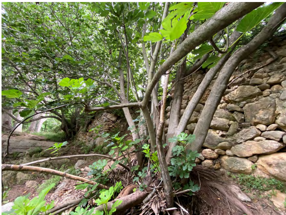
Imatge 16. Detall marge solsit a reconstruïr
