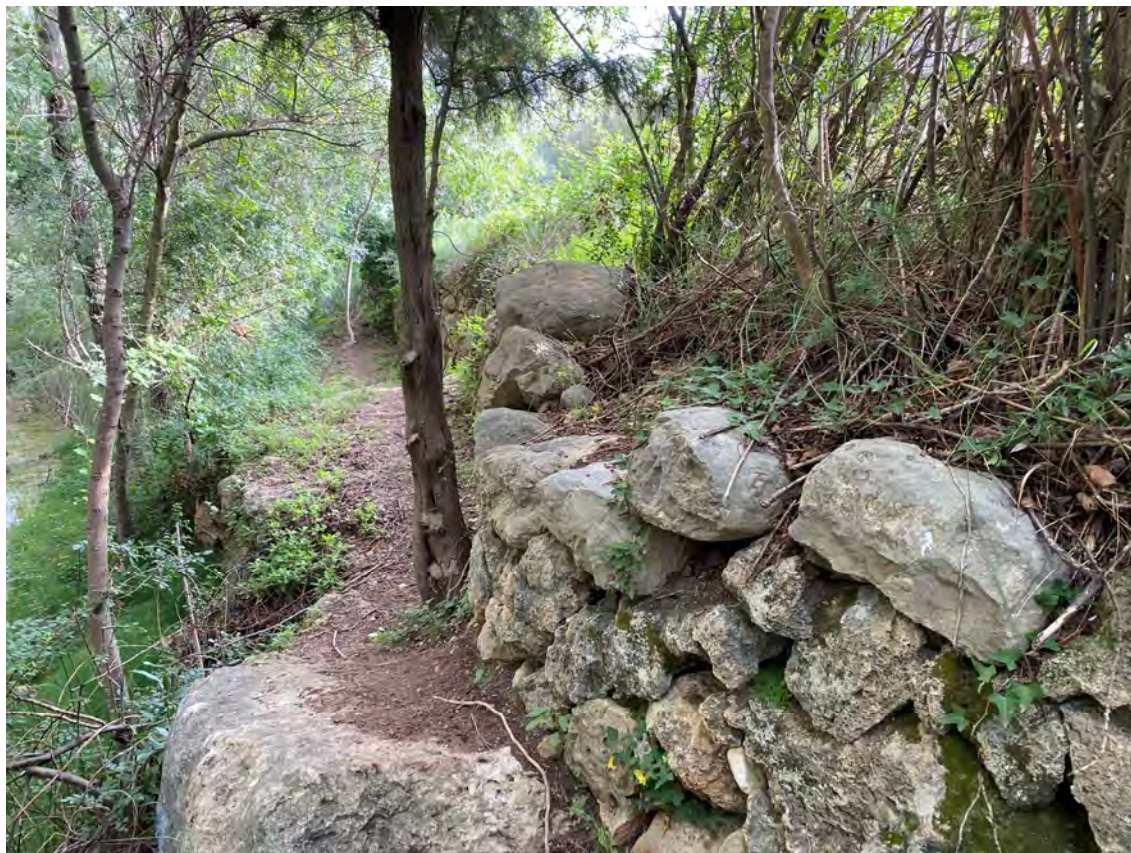
Imatge 5. Barana recolzament cable acer
