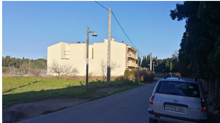
Vista 02 (tram a soterrar)
