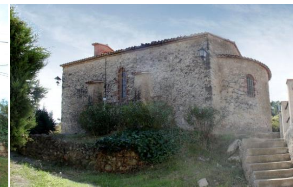
Façanes nord-est i nord-oest.
