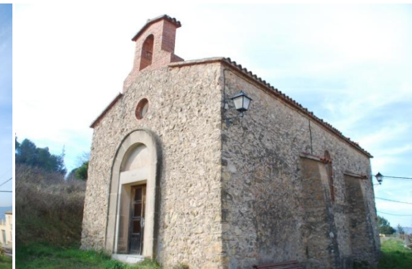
Façanes sud-est i nord-est.
