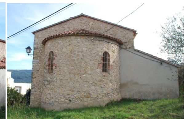
Façana posterior, amb orientació nord-est.
