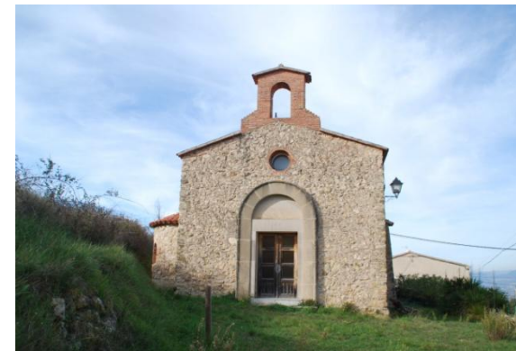
Façana principal, amb orientació sud-est.
