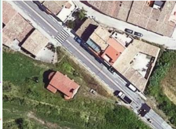
Volum aïllat de la capella, al costat de la carretera.
