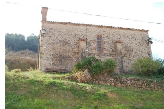
Façana nord-est, amb els contraforts.
