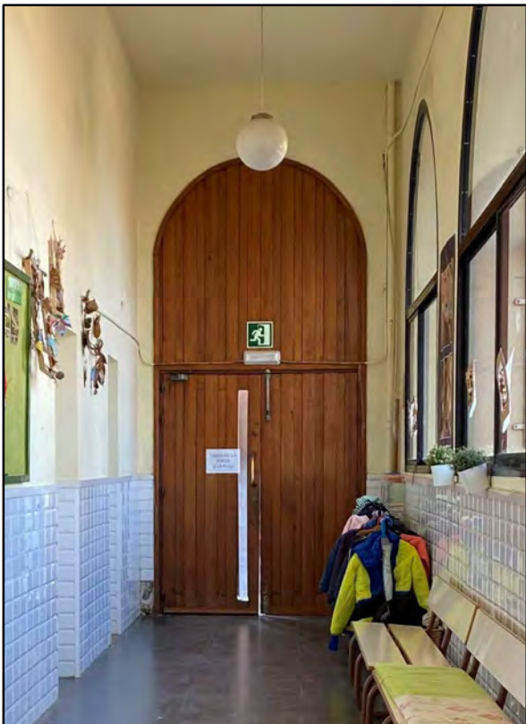
ESTAT ACTUAL PORTA A SUBSTITUIR
