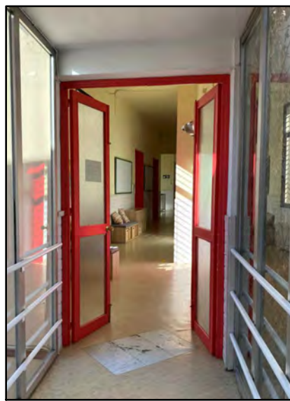
ESTAT ACTUAL PORTA A SUBSTITUIR
