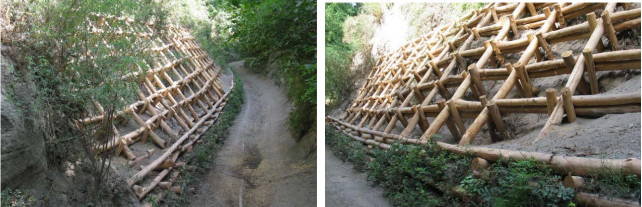
Imatge de l'enreixat Vesubi. En aquest cas, està recolzat sobre un entramat situat a peu de talús.
