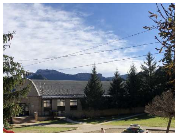
Imagen 04. Estado actual exterior cubierta pabellón
