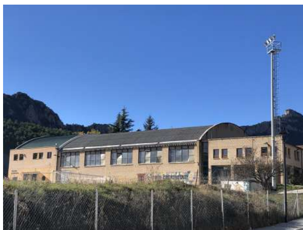
Imagen 03. Estado actual exterior cubierta pabellón.
