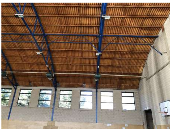
Imagen 01. Estado actual cubierta interior pabellón.
