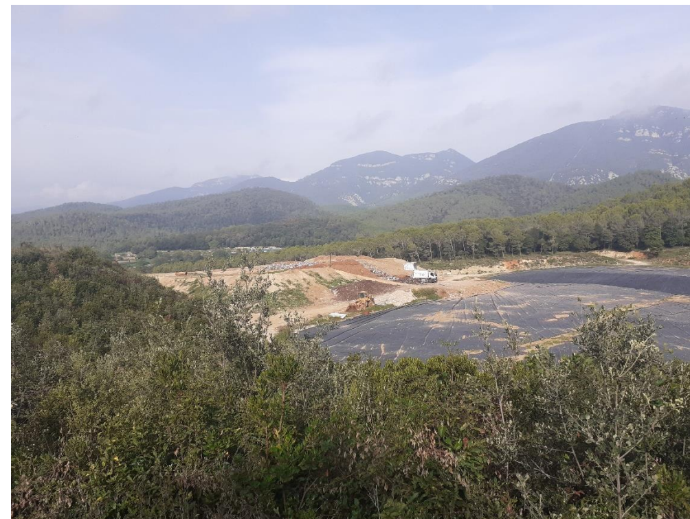
3. Vista general des del cap de talús de la zona d'adequació. Al fons la cel·la d'abocament actual.
