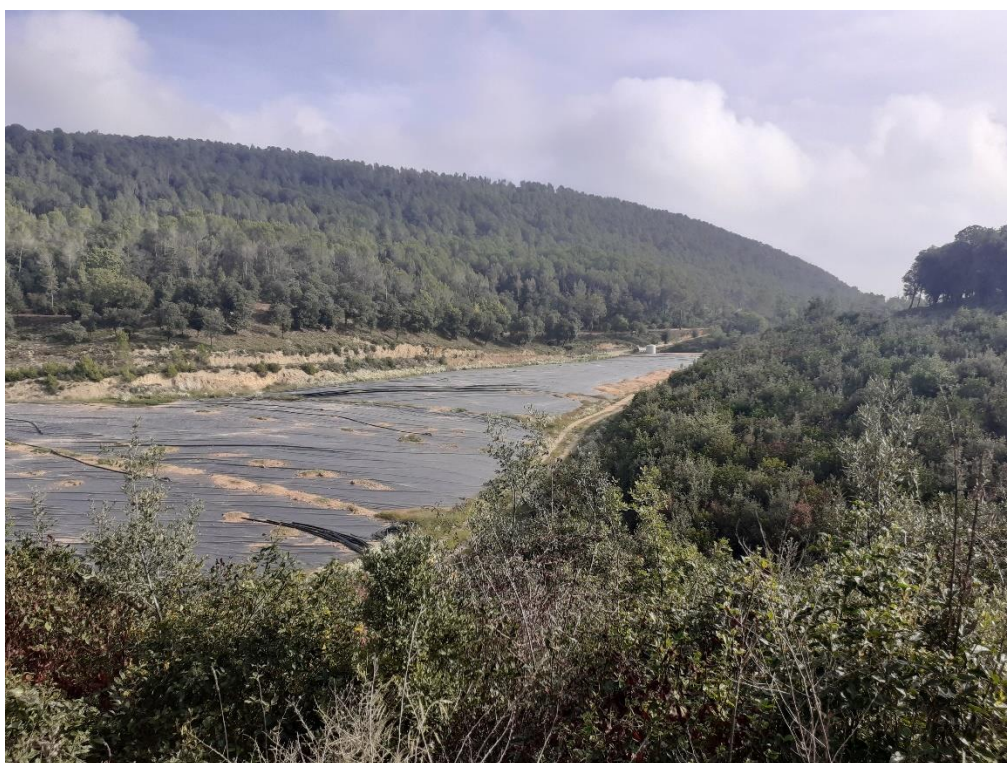
2. Vista general des del cap de talús de la zona d'adequació. Al fons la futura zona d'implantació del nou centre de valorització.
