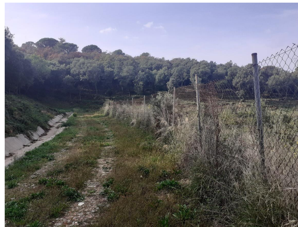
4. Camí perimetral a condicionar sobre el cap de talús de la zona a adequar.
