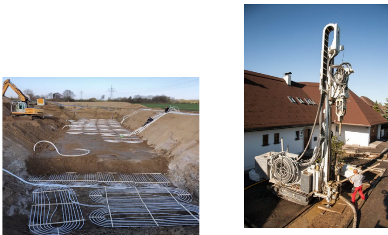
Figura 8. Diferents alternatives de instal·lacions de geotèrnia amb intercanvi a superfície o en pous
