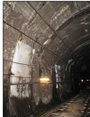
Foto 16: Filtració capcer+volta.
