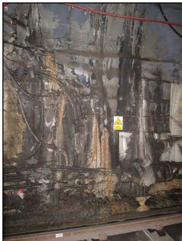
Foto 3: Filtració capcer PK 103+660 v2.
