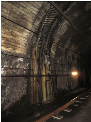
Foto 15: Filtració capcer+volta.
