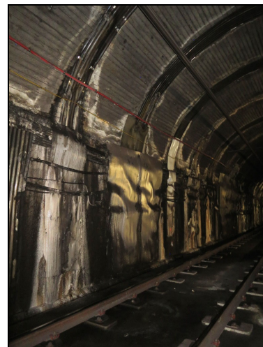
Foto 6: Filtracions capcer+volta.
