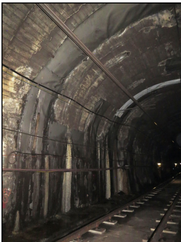
Foto 17: Filtració capcer+volta..
