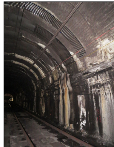
Foto 18: Filtració capcer+volta.
