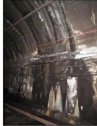
Foto 14: Filtració capcer+volta.
