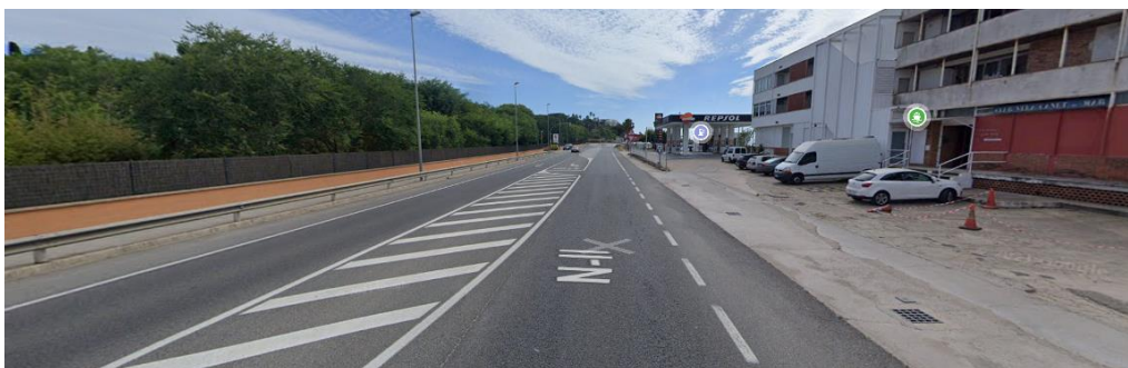
Vista general de la N-II, en el punt objecte de col·locació del nou pas de vianants semaforitzat.
