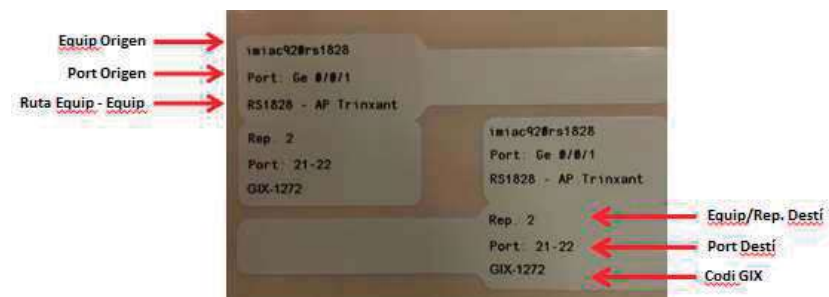
Il·lustració 8. Exemple rotolació fuetons de fibra
