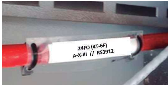
Il·lustració 7. Exemple retolació màniga de fibra
