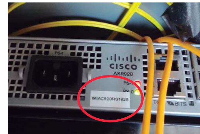
Il·lustració 5. Exemple retolació equip de xarxa
