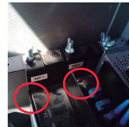
Il·lustració 6. Exemple retolació Repartidors de fibra
