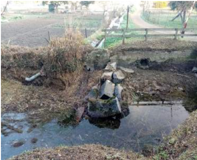
Segona i tercera presa de reg.
