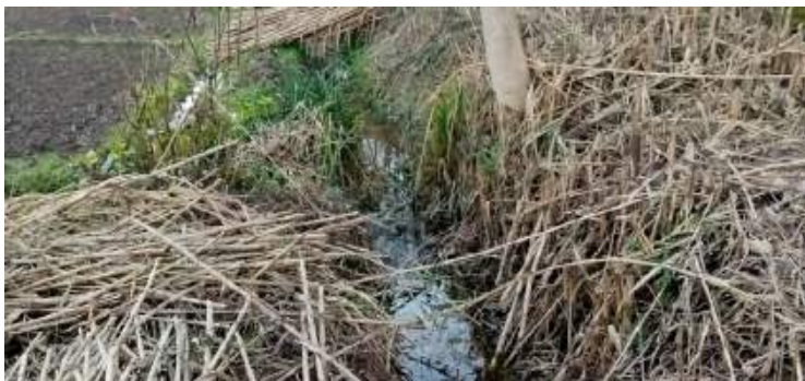
Figura 4. Canalització de les filtracions en l'extradós de la mota.
