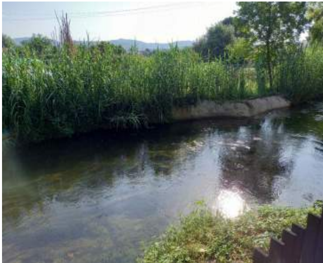
Vista del tram entre els carrer de Joan Roig i Jalpí i carrer Agudes, reparat amb unitat.
