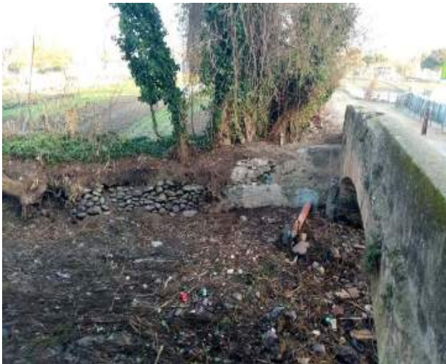
Vista aigua amunt de pont del carrer de Joan Roig i Jalpi, primera presa de reg.
