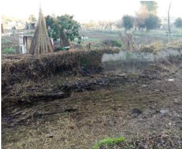
Vista del tram reparat del marge esquerre de la Sèquia.
