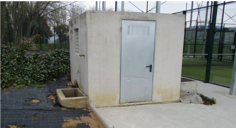
Imatge 1 Escomesa de la pista de padel de la zona esportiva
