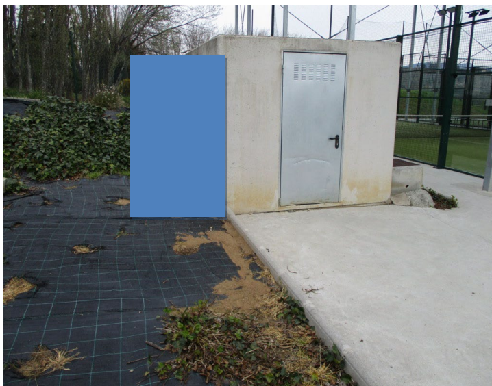
Imatge 4 espai on s'ubicarà l'inversor
