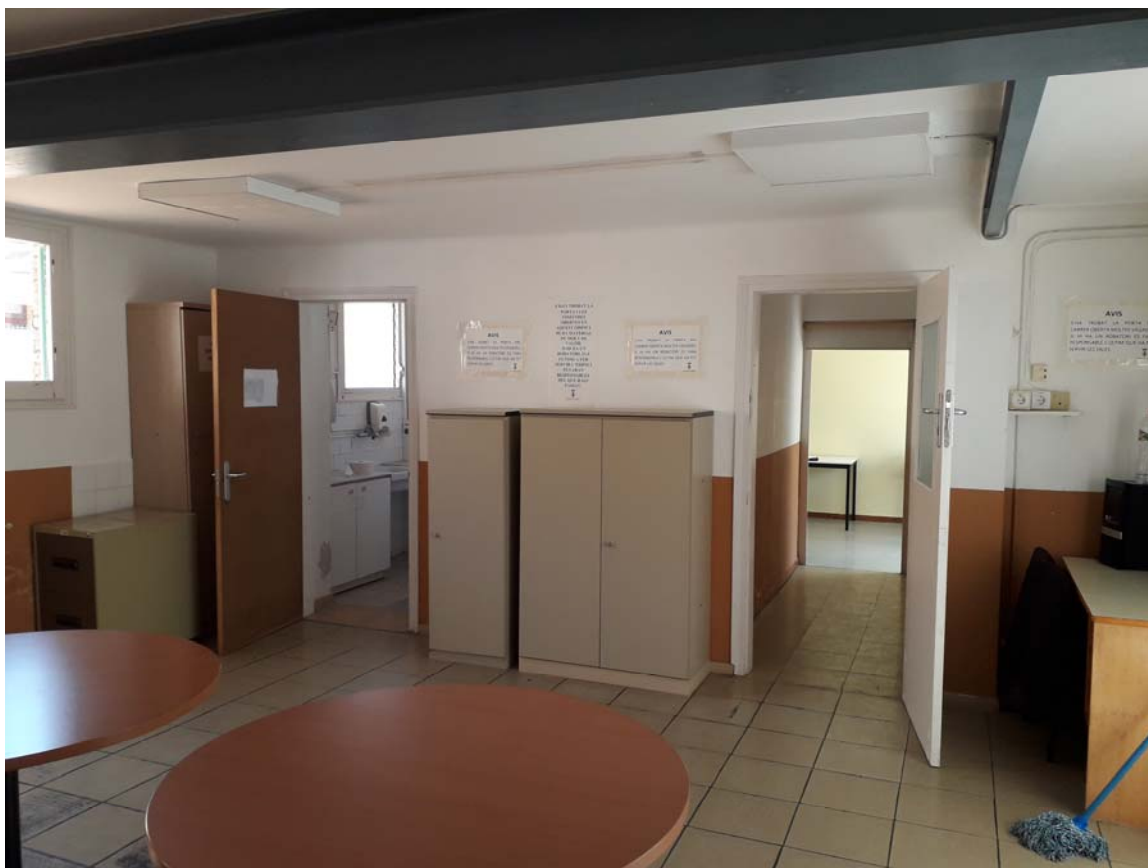
Fotografies de l'estat actual de l'interior del local
