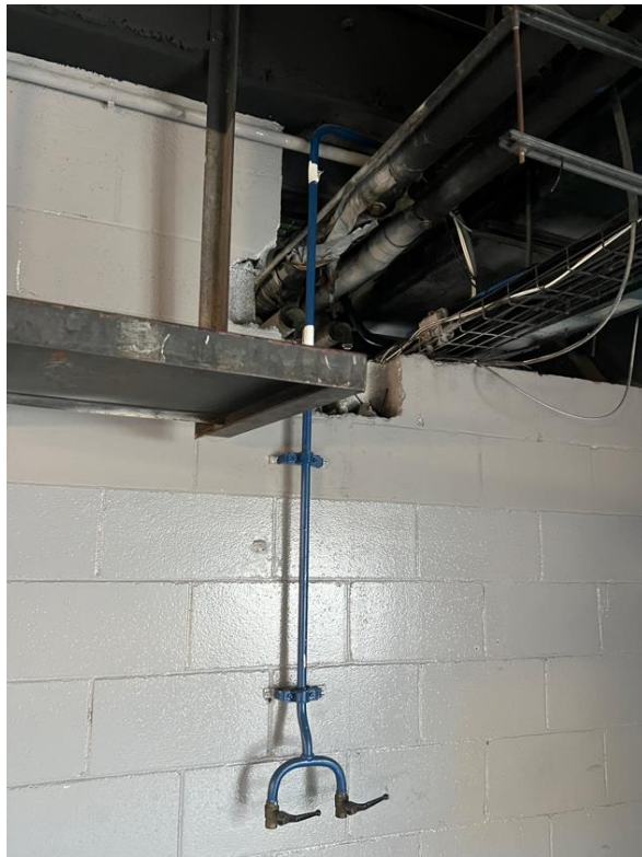
Connexions d'aire comprimit dels boxs amb 2 vàlvules de tall
