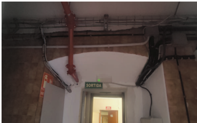
Foto 1. Planta soterrani. Creuament dels serveis existents
