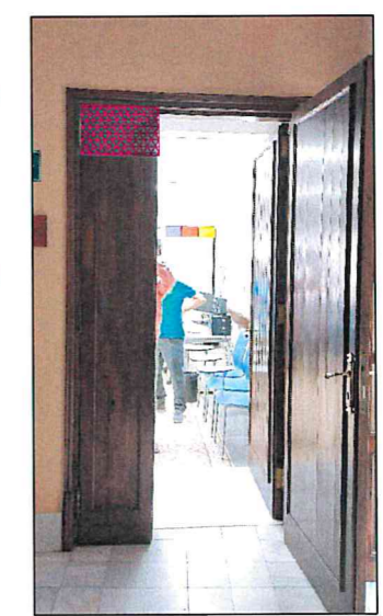
DETALL 2. Modificació de les portes. Fer una part fixa superior per on passar les línies
