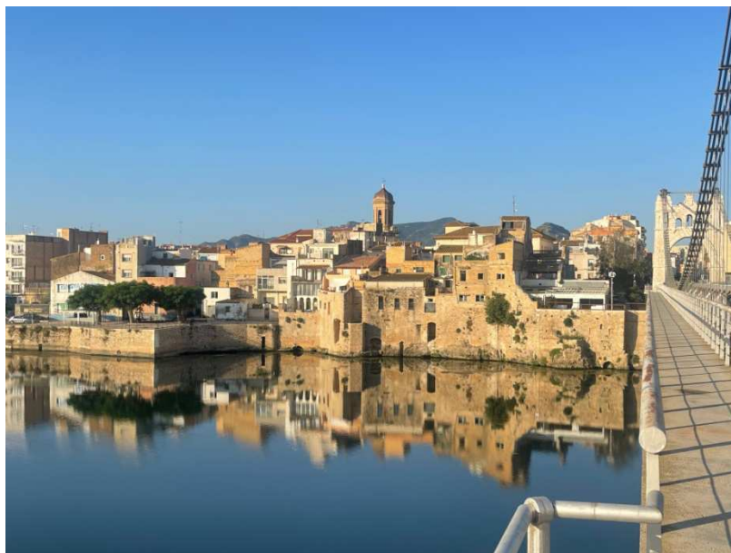
Tram 2 de l'actuació, entre la Plaça del Poador i el Pont Penjant.
