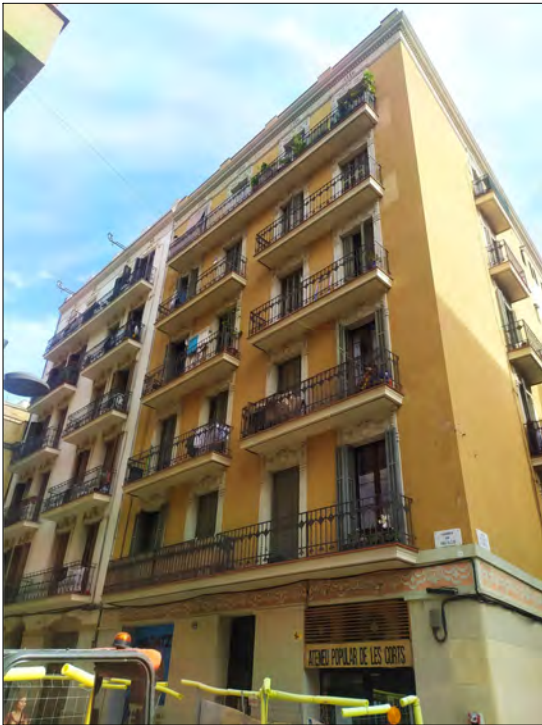
ESTAT ACTUAL FAÇANA C/GALILEU
