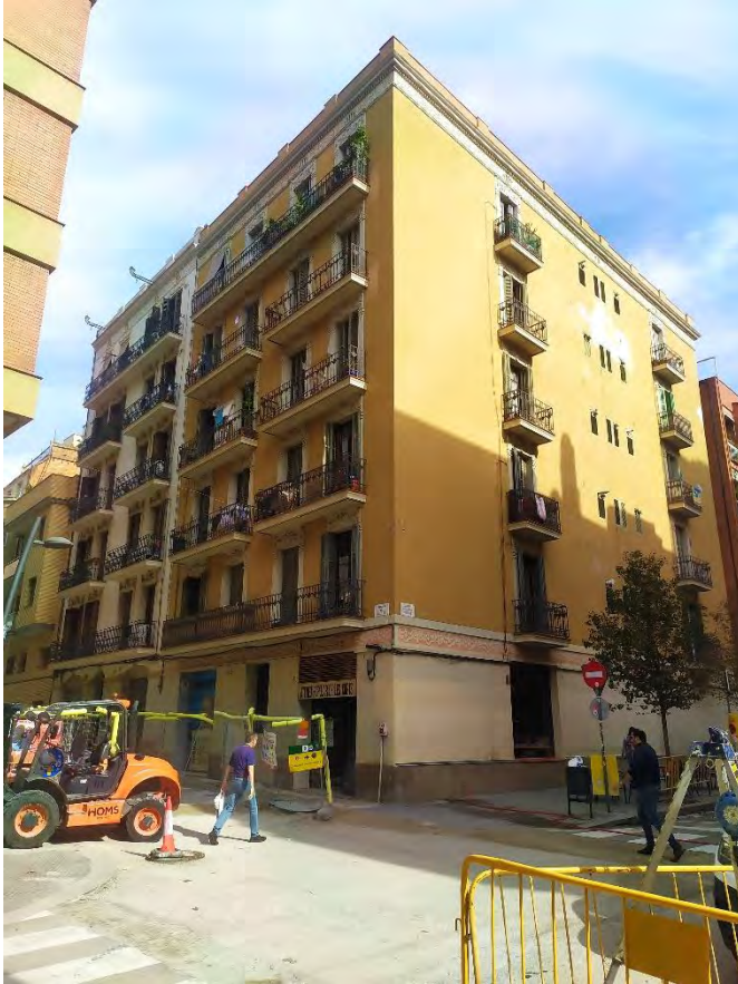
Vista general de la finca
