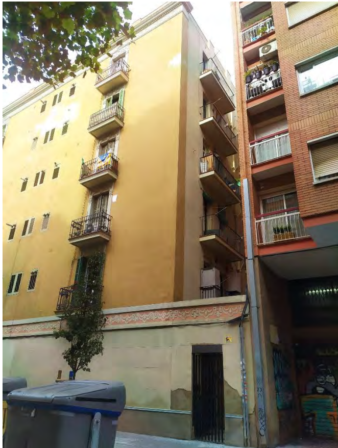
Façana carrer Evarist Arnús amb pati interior
