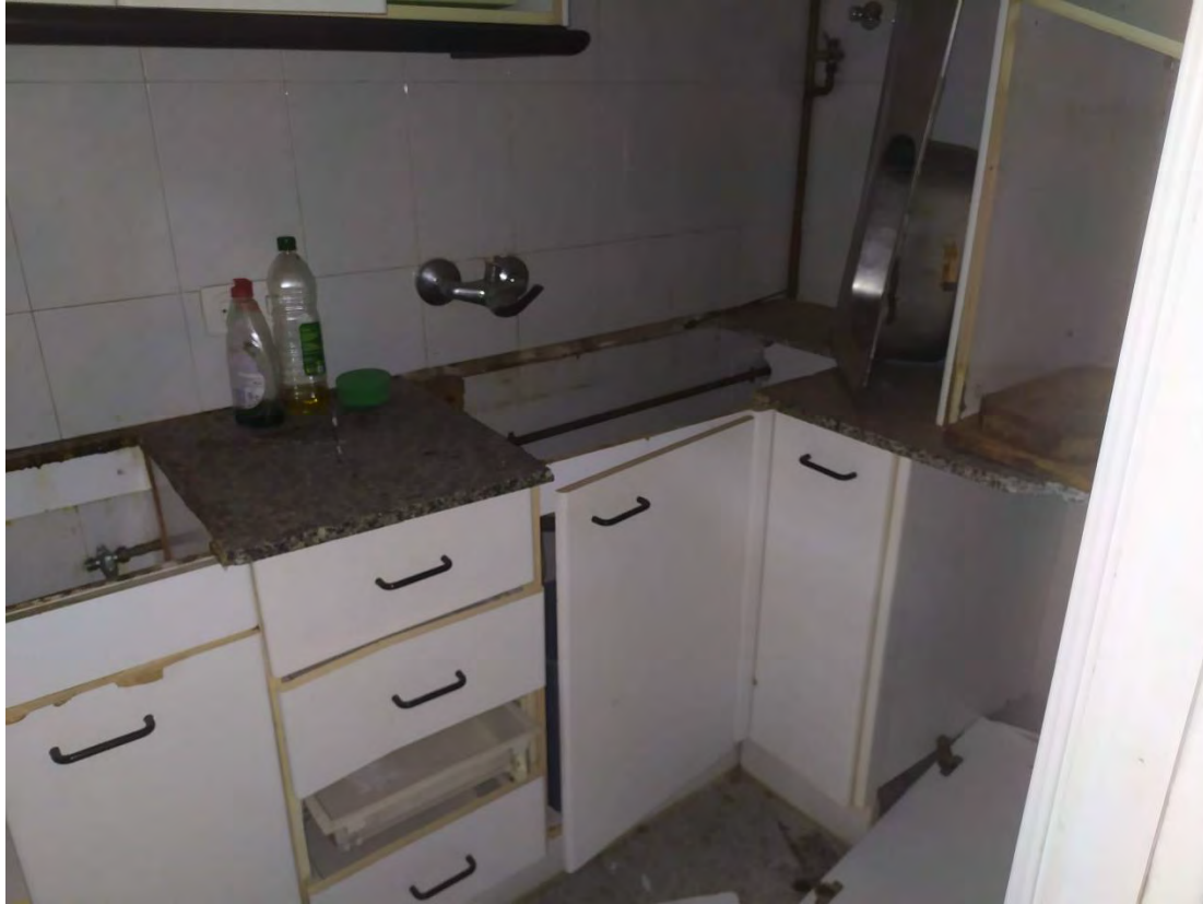
Interior habitatge – cuina
