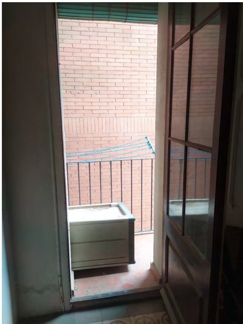
Interior habitatge – sortida terrassa interior d'illa
