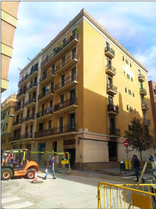
ESTAT ACTUAL EDIFICI CANTONADA
