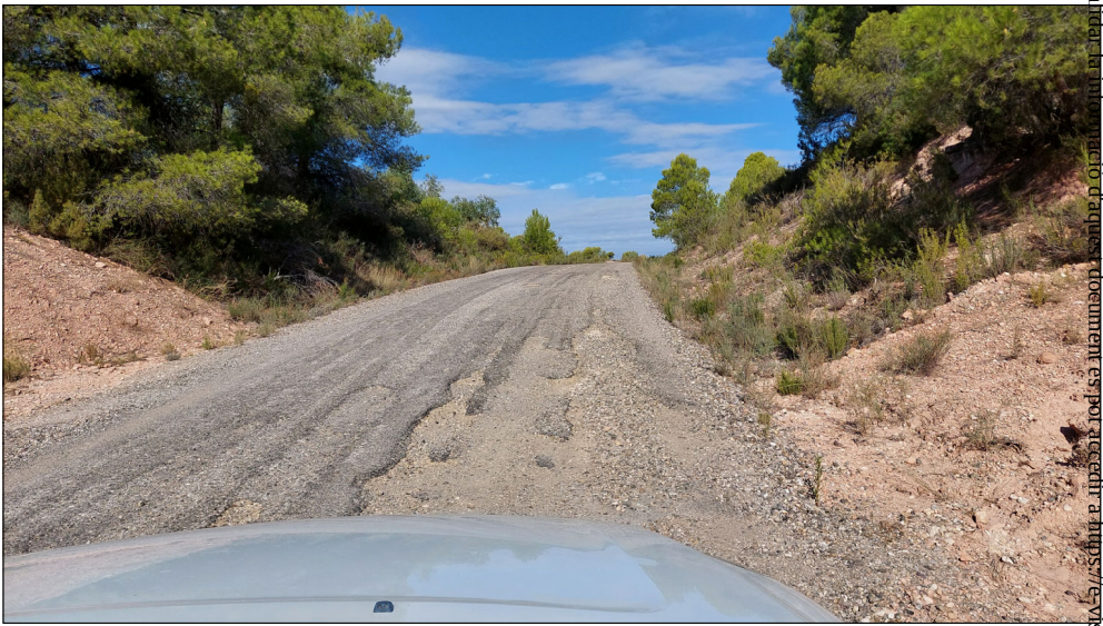
Fotografia Georeferenciada pk: 2+700
