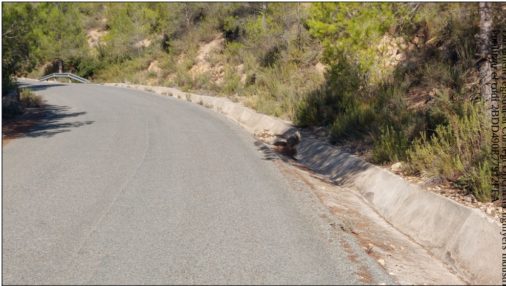
Fotografia Georeferenciada, pk: 3+000
