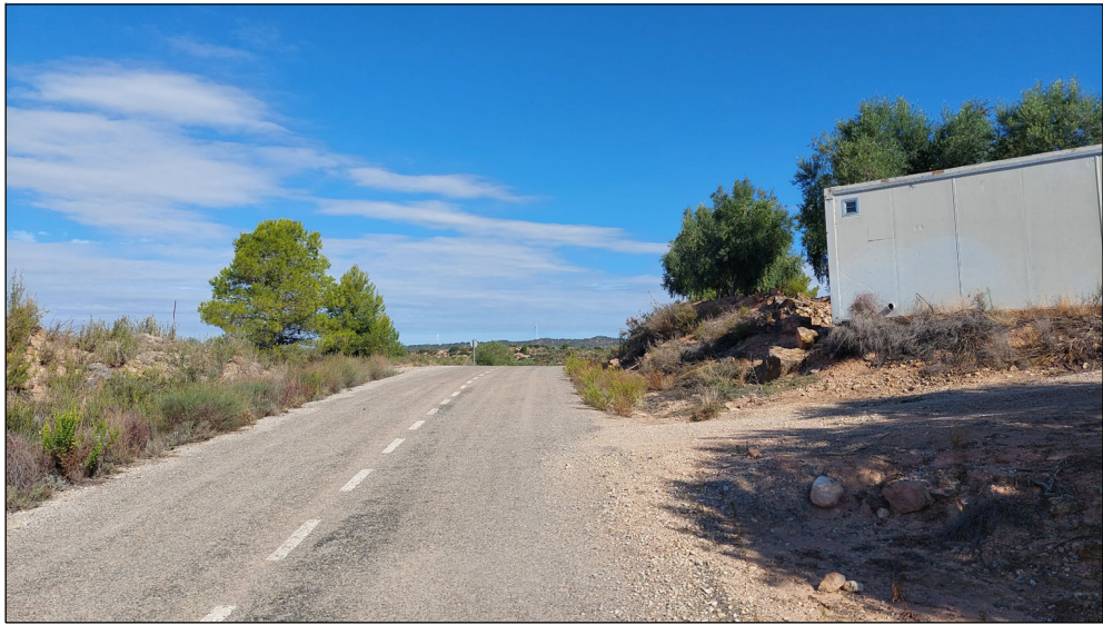
Fotografia Georeferenciada pk: 1+950
