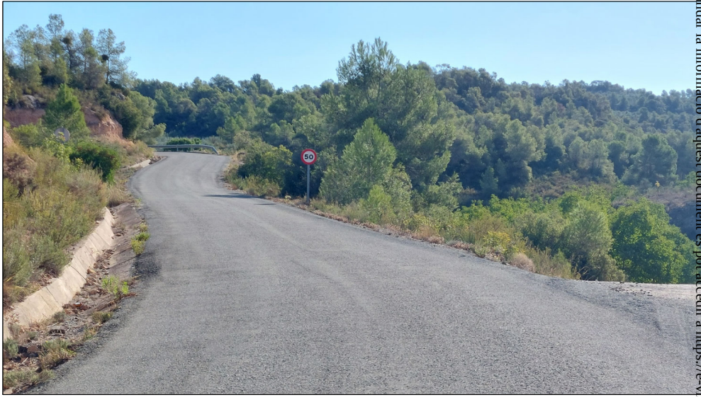
Fotografia Georeferenciada pk: 0+100
