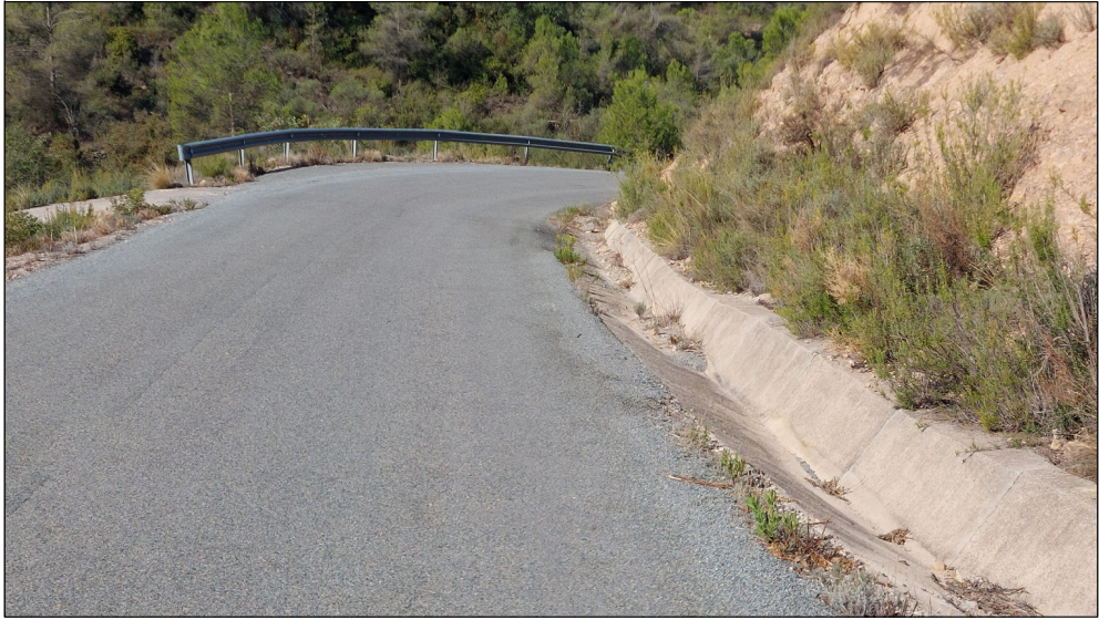
Fotografia Georeferenciada pk: 3+100
