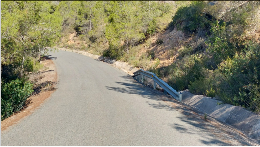
Fotografia Georeferenciada, pk: 3+800
