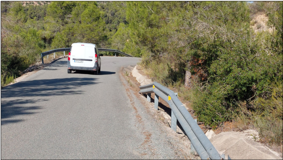
Fotografia Georeferenciada, pk: 2+900
