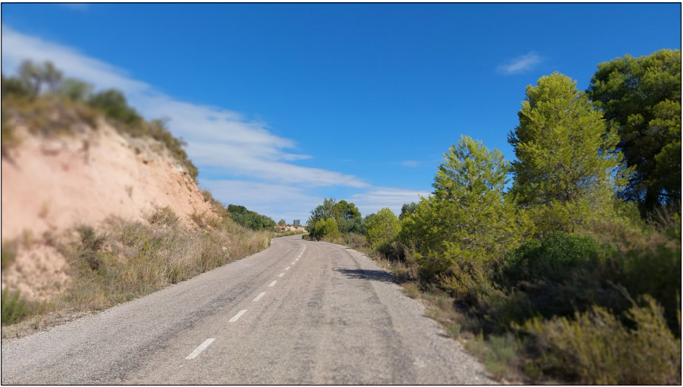
Fotografia Georeferenciada, pk: 1+300
