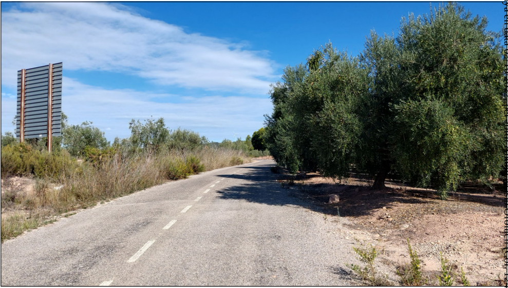
Fotografia Georeferenciada, pk: 1+150
