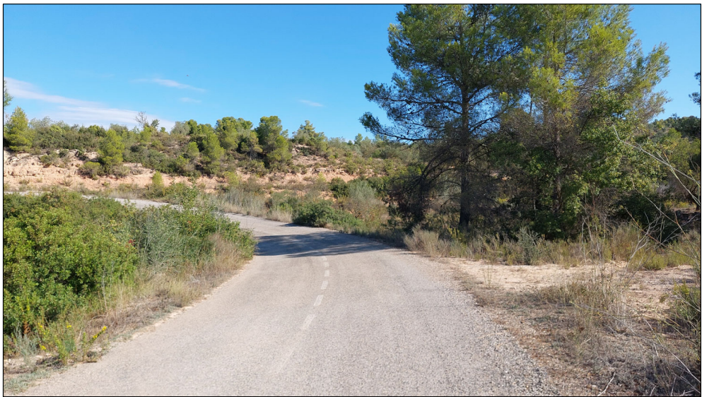
Fotografia Georeferenciada, pk: 1+600
