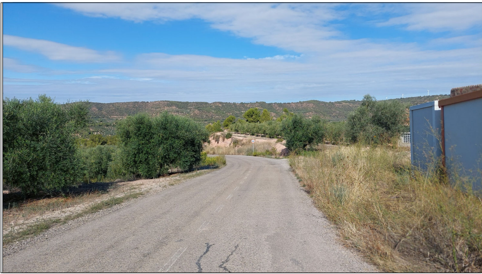
Fotografia Georeferenciada, pk: 0+800
