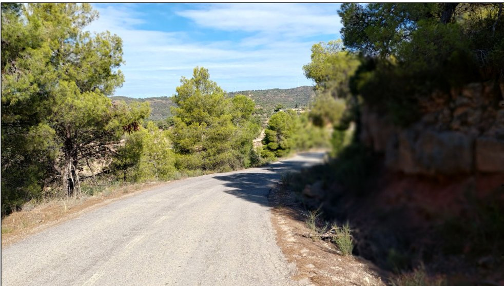
Fotografia Georeferenciada pk: 0+600
