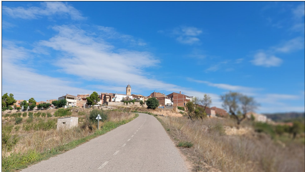
Fotografia Georeferenciada pk: 0+150
