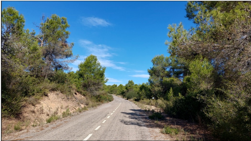
Fotografia Georeferenciada pk: 2+800
