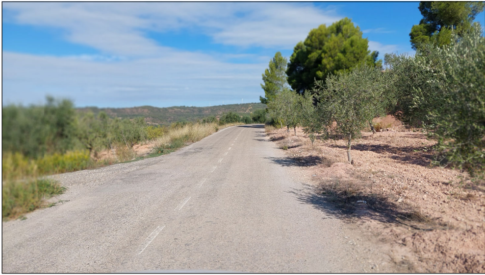
Fotografia Georeferenciada pk: 1+000
