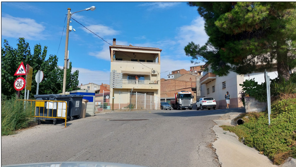
Fotografia Georeferenciada, pk: 0+025
