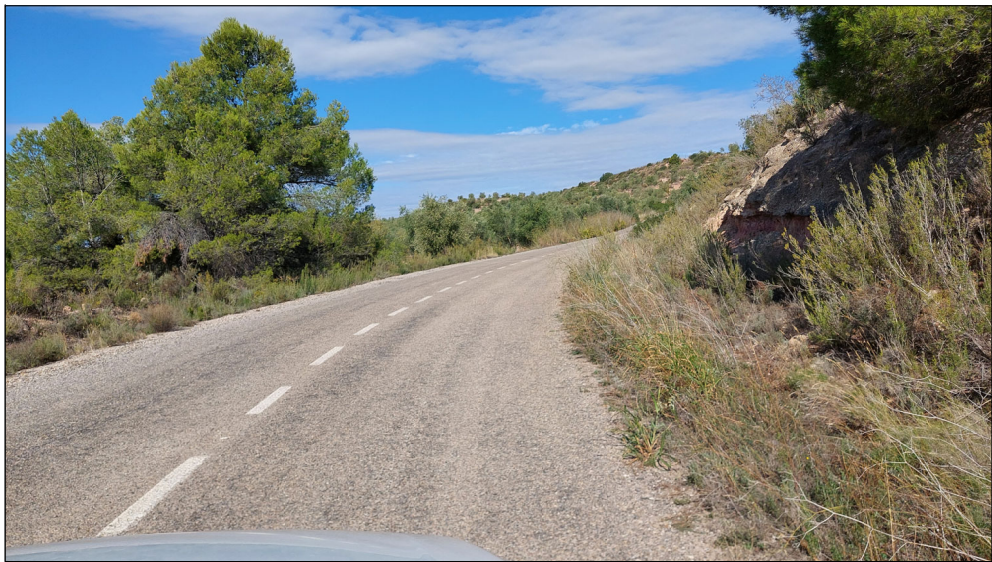
Fotografia Georeferenciada pk: 1+500
