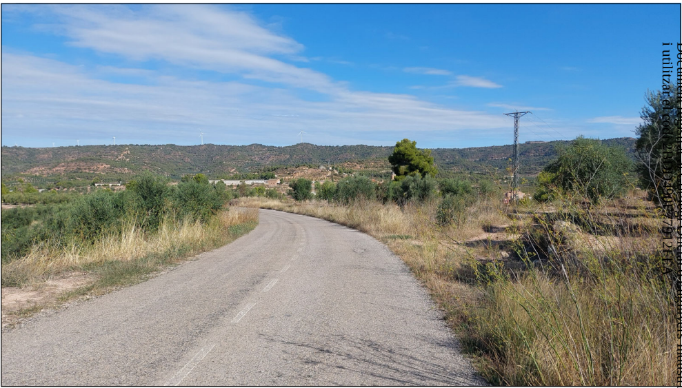
Fotografia Georeferenciada, pk: 0+900
