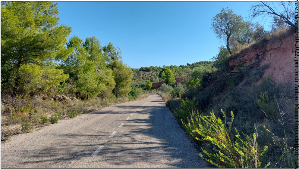
Fotografia Georeferenciada, pk: 2+300
