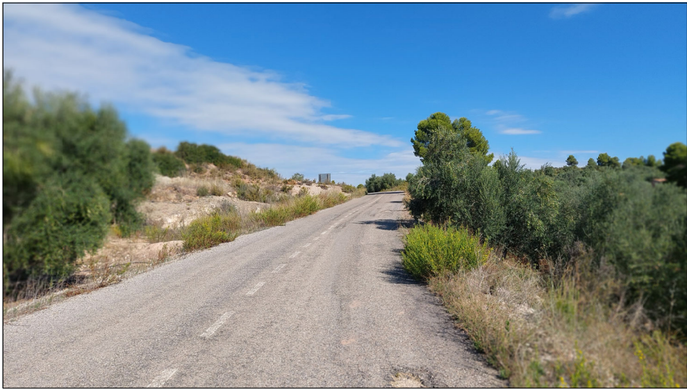
Fotografia Georeferenciada, pK 1+200
