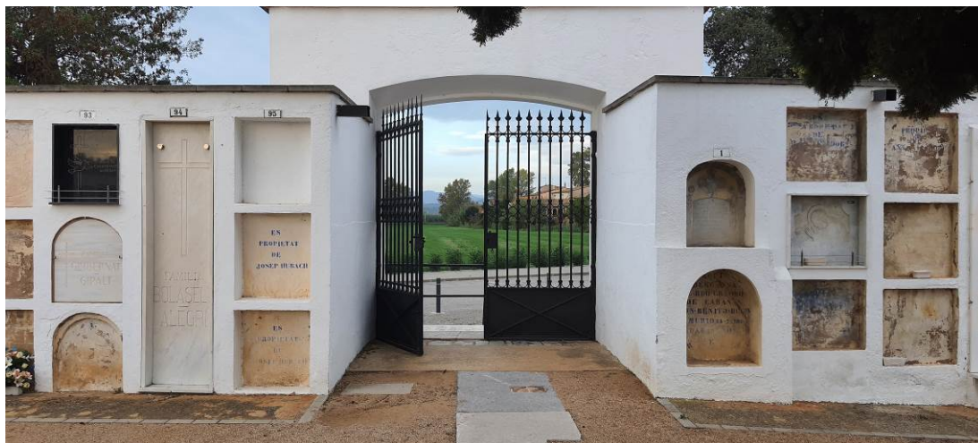
Interior del cementiri a on s'observa la vorera amb pintat d'oxid i la llamborda perimetral i l'acabat dels volums de nínxols amb remolinat i pintat de color blanc i la peça superior de remat.
