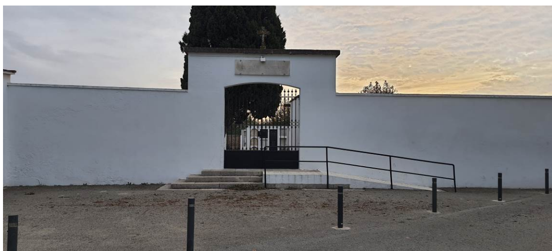
Façana principal de ponent amb l'accés que no s'ajusta a la normativa d'accessibilitat.
