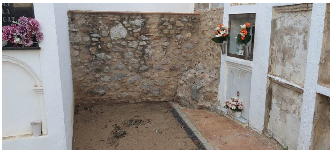
Zona per on s'ha de fer la connexió amb l'ampliació, que requerirà la demolició de la paret de pedra i la continuació de la reixa i la vorera.
