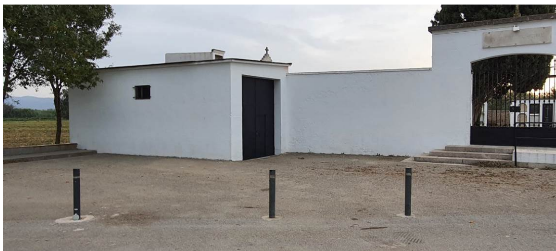
Façana principal de ponent amb el cobert a enderrocar.
