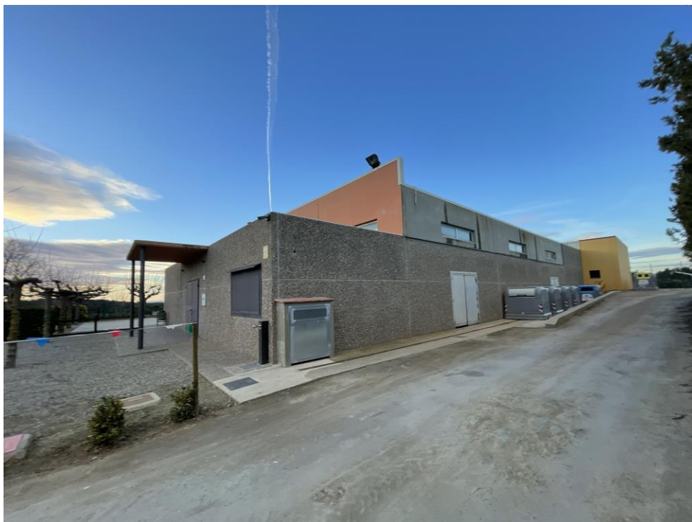
Imatge façana nord
