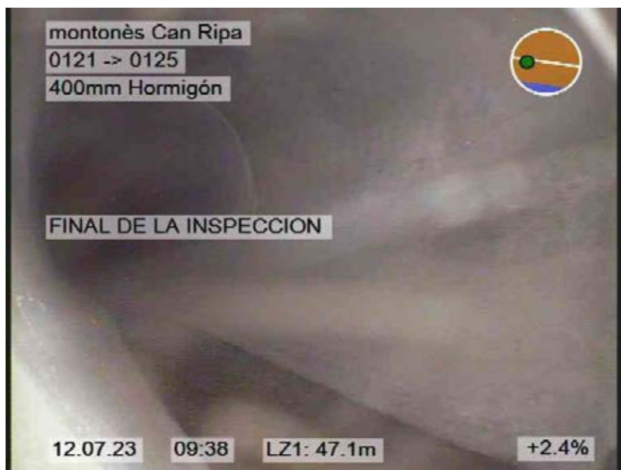
7.jpg, 00:03:40, 47.10m FINAL DE LA INSPECCION
