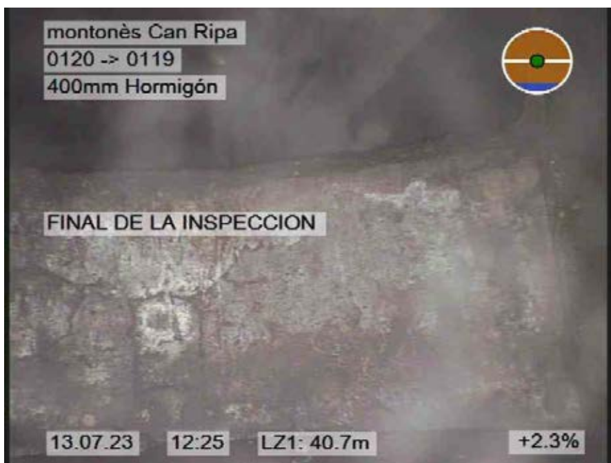
14.jpg, 00:02:54, 40.70m FINAL DE LA INSPECCION
