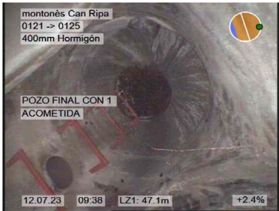
6.jpg, 00:03:35, 47.10m POZO FINAL CON 1 ACOMETIDA
