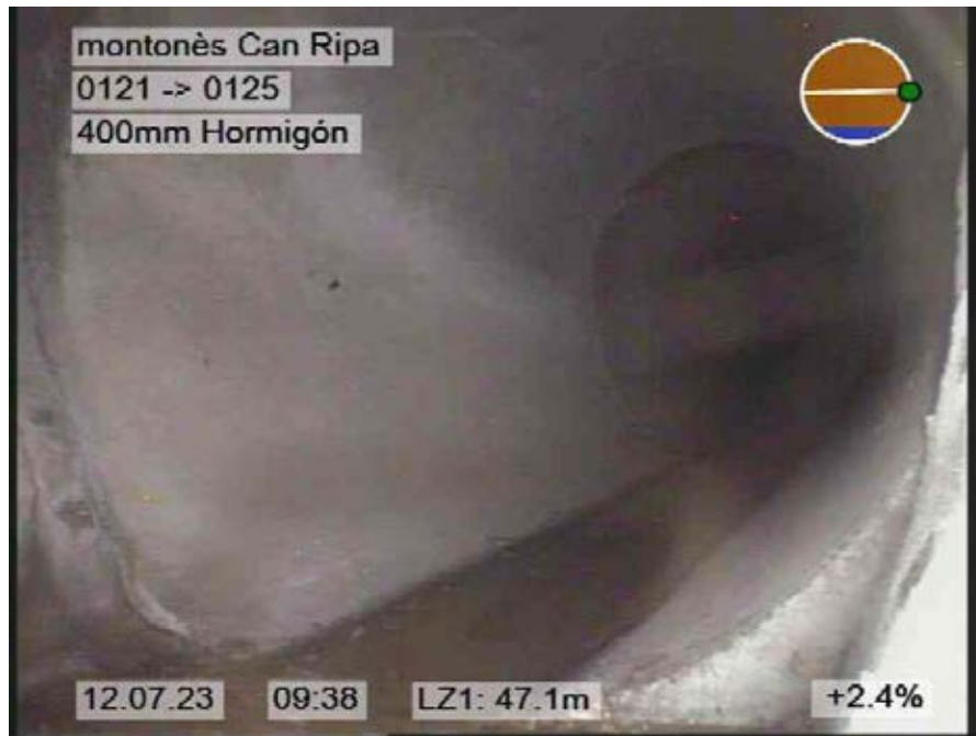
8.jpg, 00:03:40, 47.10m FINAL DE LA INSPECCION
