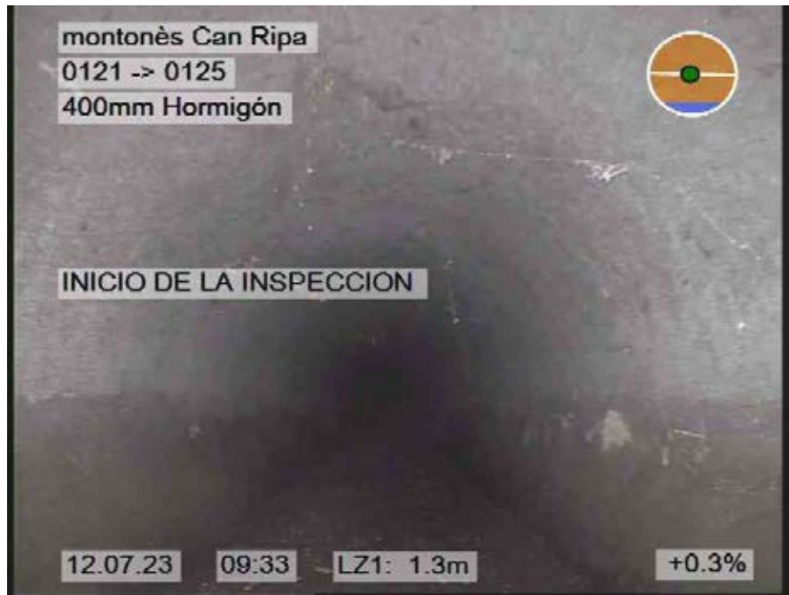
4.jpg, 00:00:00, 1.30m INICIO DE LA INSPECCION
