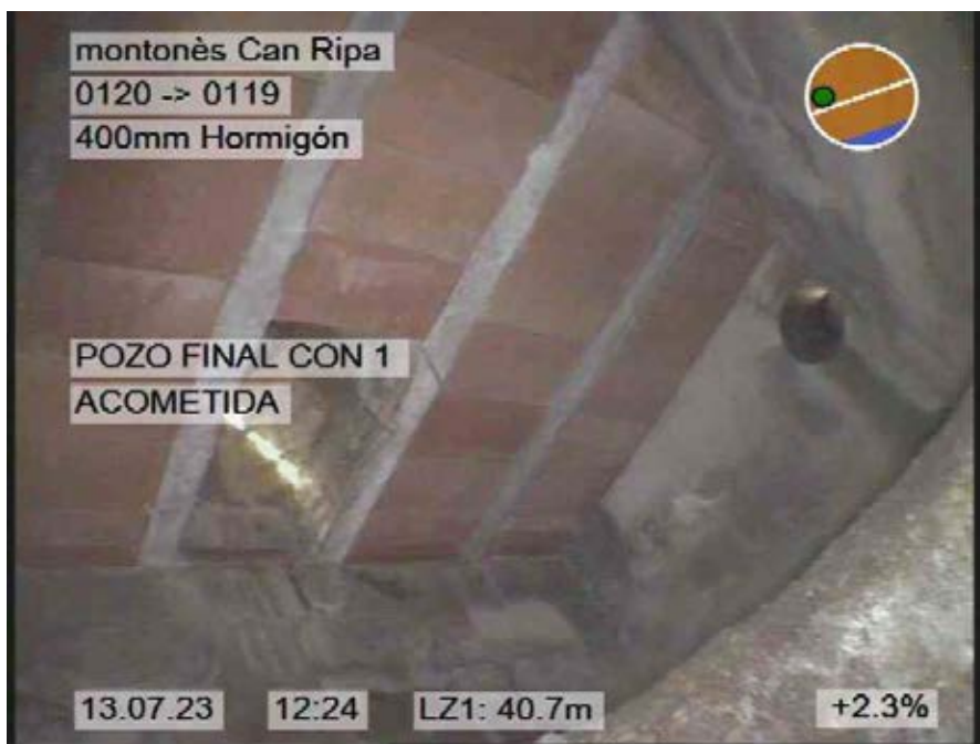
13.jpg, 00:02:43, 40.70m POZO FINAL CON 1 ACOMETIDA
