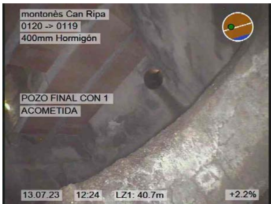
12.jpg, 00:02:43, 40.70m POZO FINAL CON 1 ACOMETIDA
