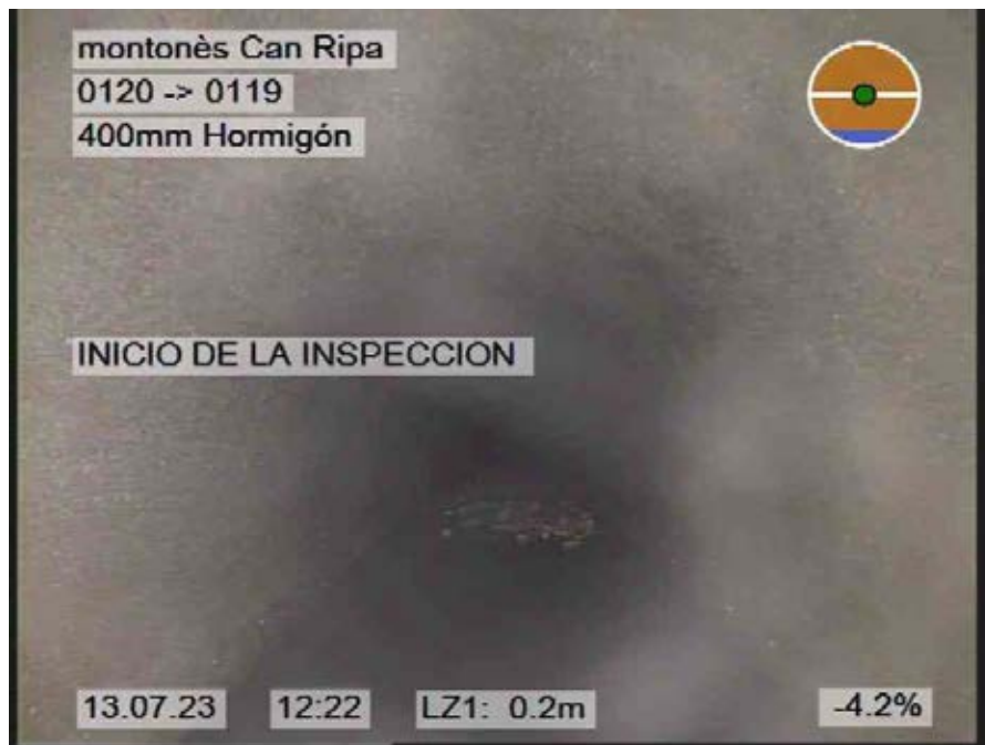
11.jpg, 00:00:00, 0.20m INICIO DE LA INSPECCION
