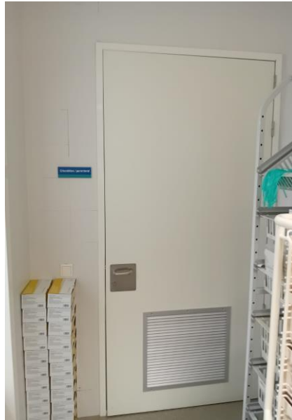
Porta accés a la sala SAS
