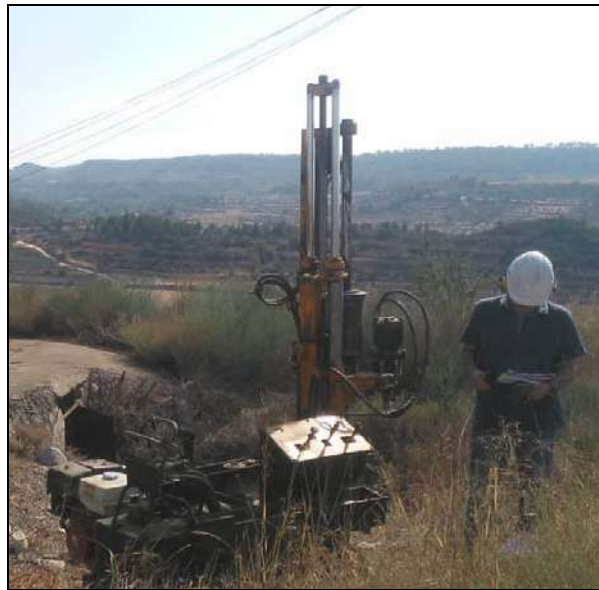
Fotografia 2. Vista de la màquina utilitzada per a la realització del sondeig a rotació amb bateria continua.
