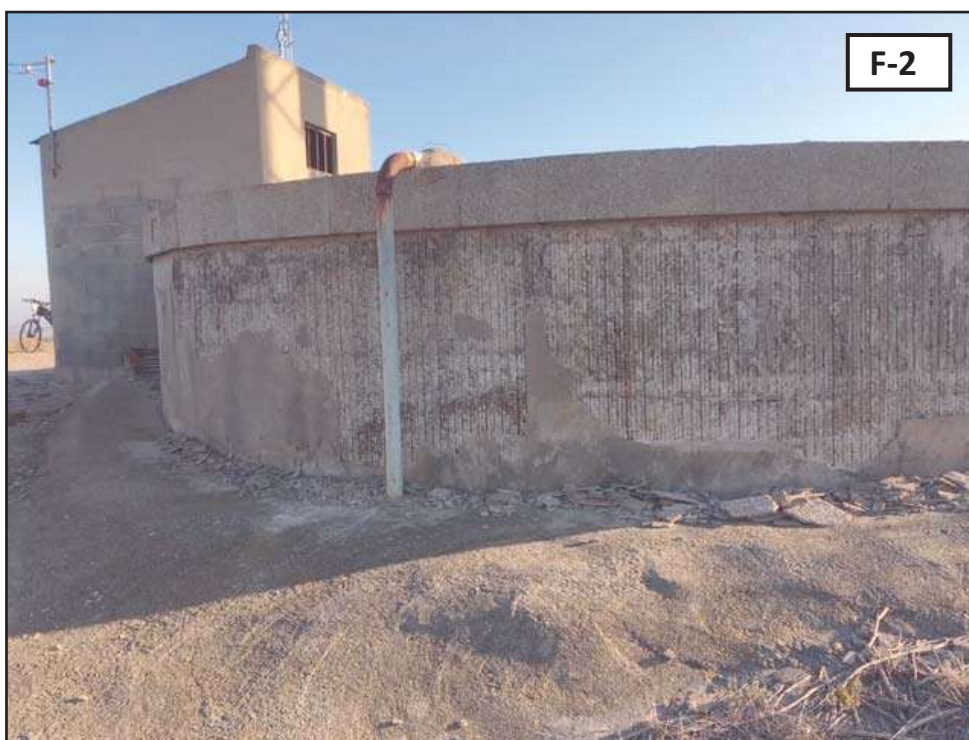
Fotografies 1 i 2: Detall de l'emplaçament dels dipòsits actualment existents.
