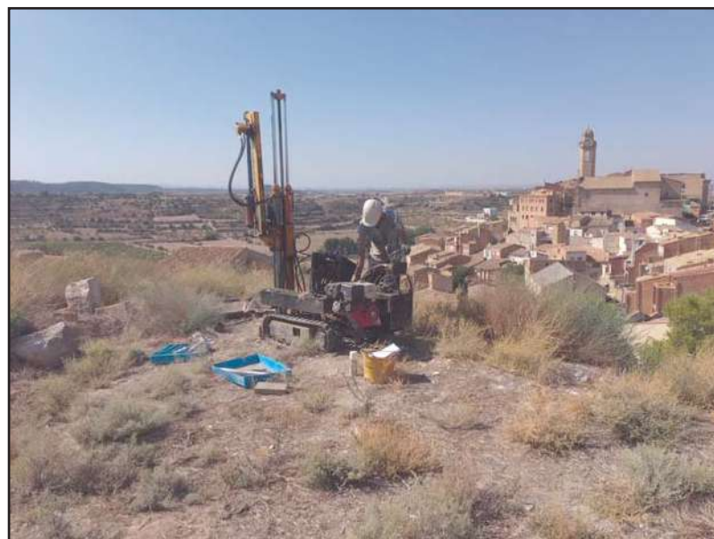
Fotografia 1. Vista de l'emplaçament de la màquina per a la realització del sondeig a rotació amb bateria contínua S-1.
