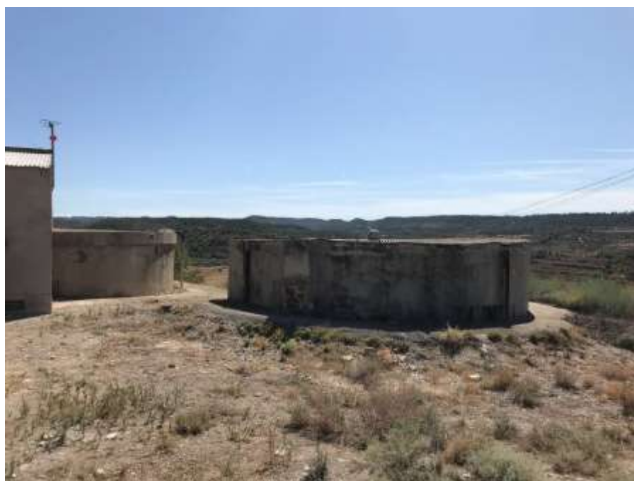
Vista del dipòsit d'aigua potable a substituir
