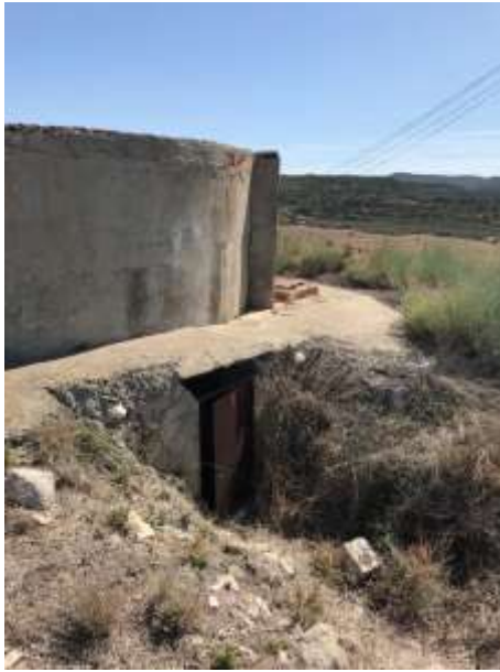
Vista lateral del dipòsit amb la caseta de la boca de buidat
