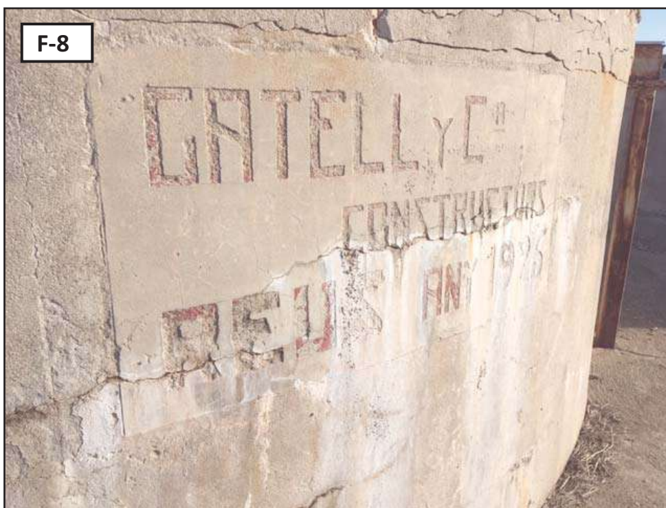
Fotografies 7 i 8: La foto superior detall de patologies de la caseta del primer dipòsit. A la figura inferior fotografia del dipòsit antic, veiem que es de l'any 1925. Presenta algunes fisures.
