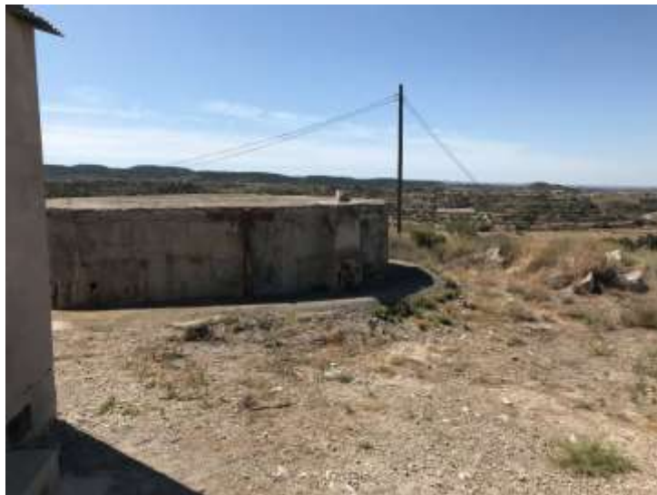
Vista del dipòsit original, a enderrocar, i detall de la caseta annexa a mantenir
