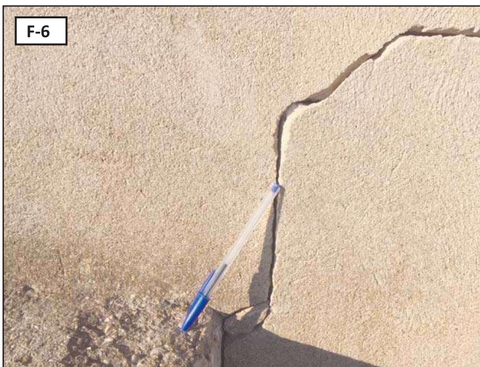
Fotografies 5 i 6: Detall d'algunes patologies que presenta la zona de la caseta del dipòsit més nou.
