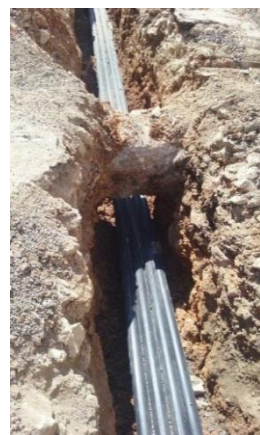
Exemple execució de cala amb detecció de serveis i minatge de canonada d'aigua.
