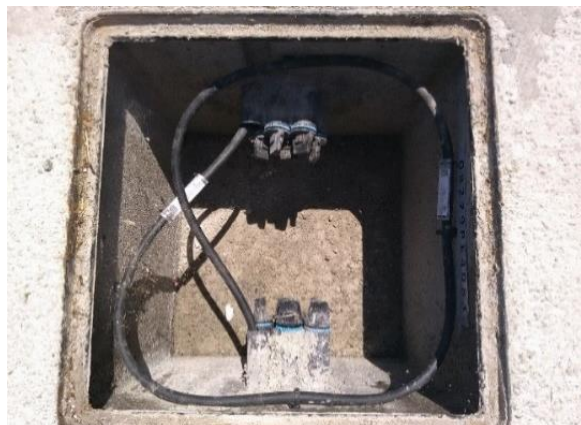
Exemple d'etiquetat de cable dins de pericó de pas.
