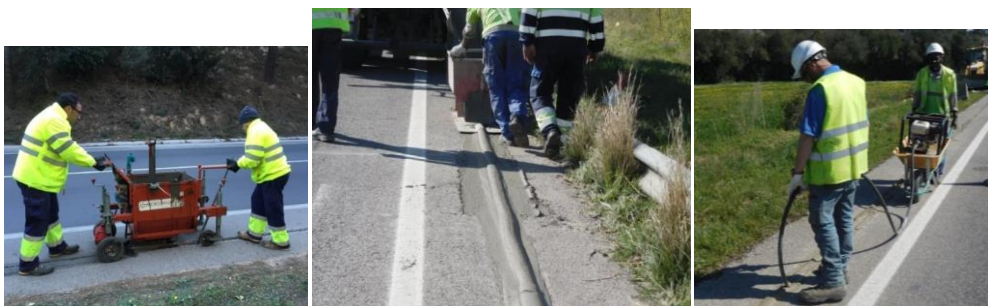
Exemple de treballs de rebliment de la rasa.
