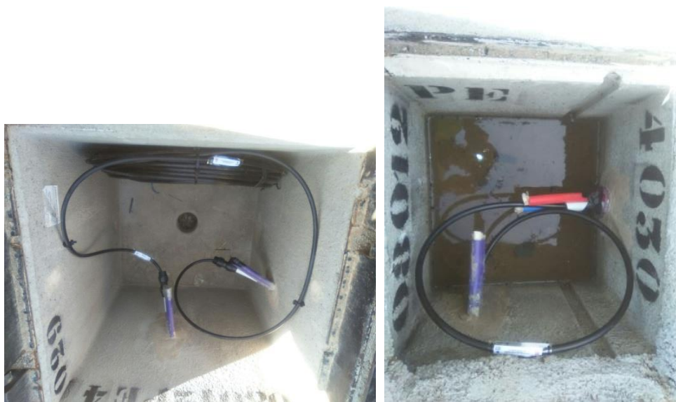
Exemples Terminació microductes en pericó
