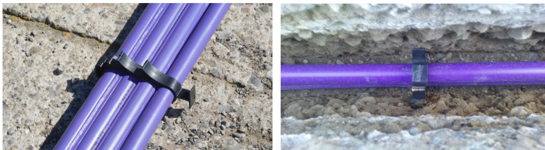
Centrador plàstic per homogeneitzar la distribució del morter.
