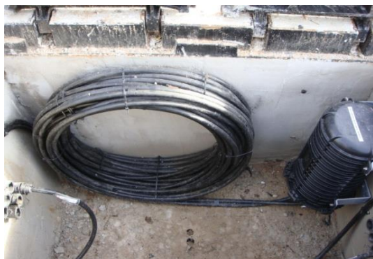
Exemples d'instal·lació de Caixes d'Empiulament dins de Pericó
