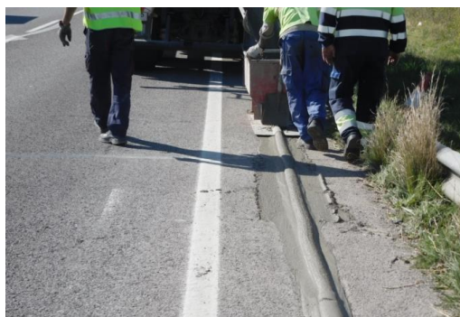
Procés de rebliment de la rasa amb morter.
