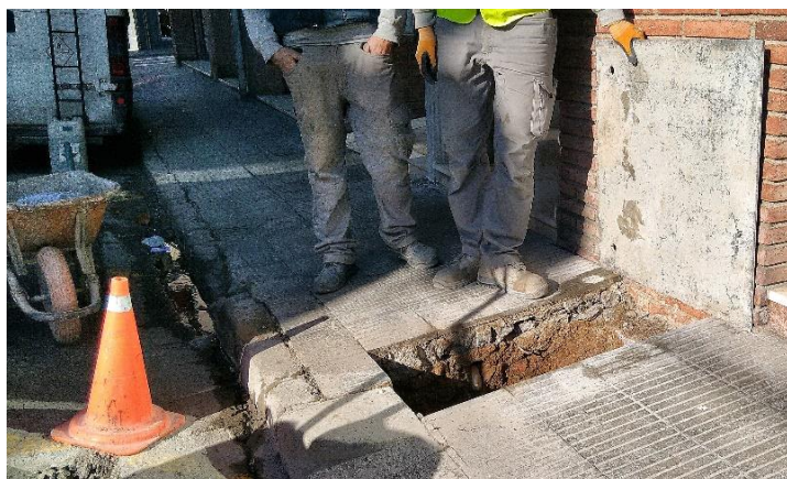
Exemple execució de cala amb detecció de serveis i minatge de canonada d'aigua.
