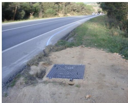
Exemple de l'estat de la canalització acabada
