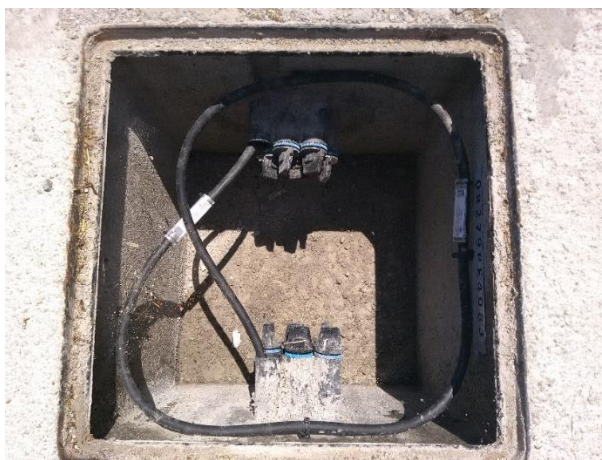
Exemple de pas de cable per pericó
