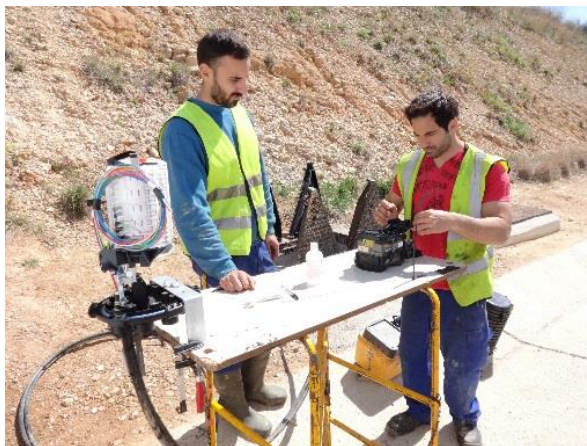
Equip d'operaris realitzant tasques de fusió en Caixa d'empialaments
