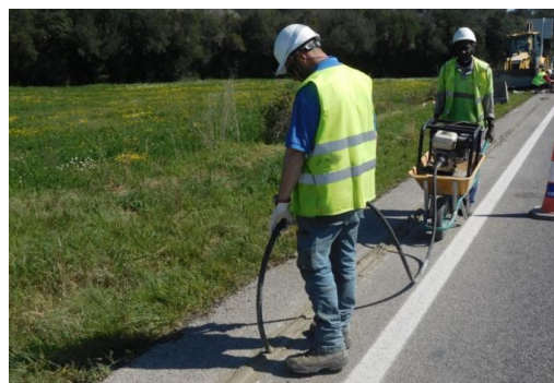
Procés de rebliment de la rasa amb morter.
