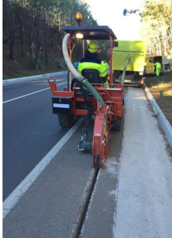
Exemple de treballs d'obertura de la microrasa
