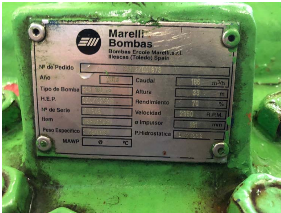
Imatge 6.- Vista placa característiques bombes
