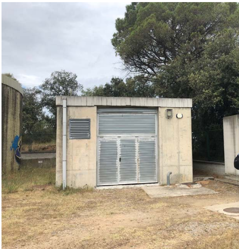
Imatge 2.- Vista exterior edifici de bombament.
