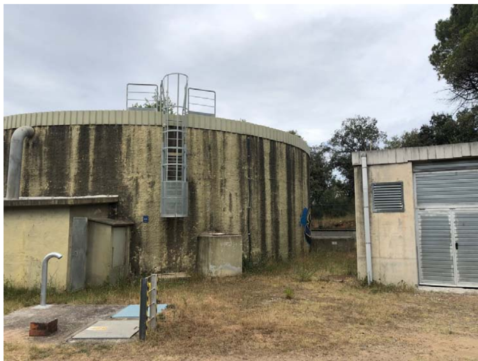
Imatge 1.- Vista exterior dipòsit Llinars i edifici bombament. (Objecte de l'actuació)
