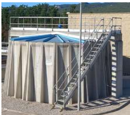
Figura 2: Recull fotogràfic de l'espessidor en funcionament.
