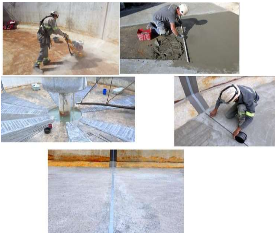
Figura 13: Recull fotogràfic dels treballs de planimetria del terra de l'espessor.
