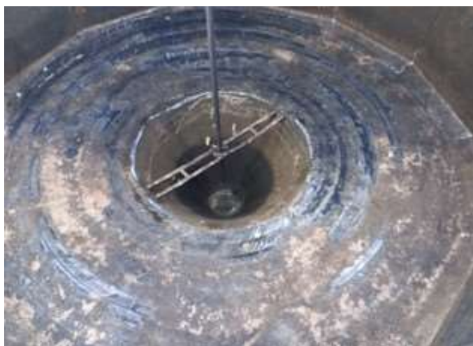
Figura 6: Recull fotogràfic de la situació interna de l'espessidor a l'aconseguir el buidat de fangs.
