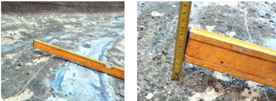
Figura 9: Imatges de l'evidència de les irregularitats del terra de l'espessor.
