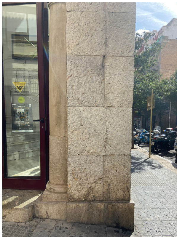
Cantonera pedra, arrambador.
