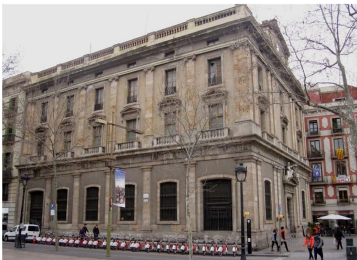
Vista del a cantonada des de la que s'aprecien les dues façanes
