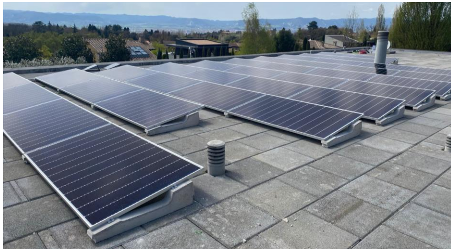
Figura 4: Estructura triangular sobre coberta plana
