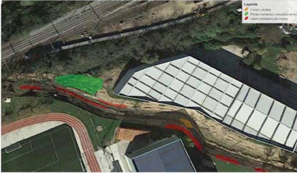
Tram 1. Pont tren fins pont GI-673
