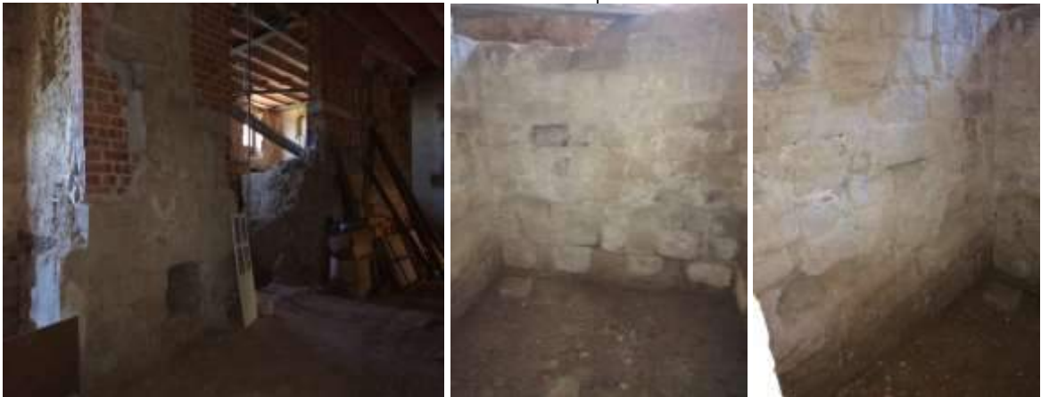
Imatges de l'àmbit situat al sud-oest i pertanyent a la torre de defensa Imatges. P. Cascante
