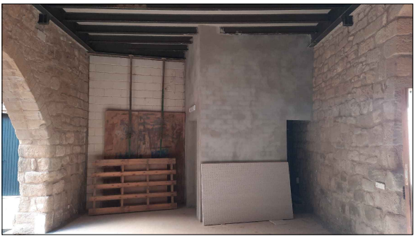
VISTA DE L'ENTRADA I LA CAIXA D'ASCENSOR
