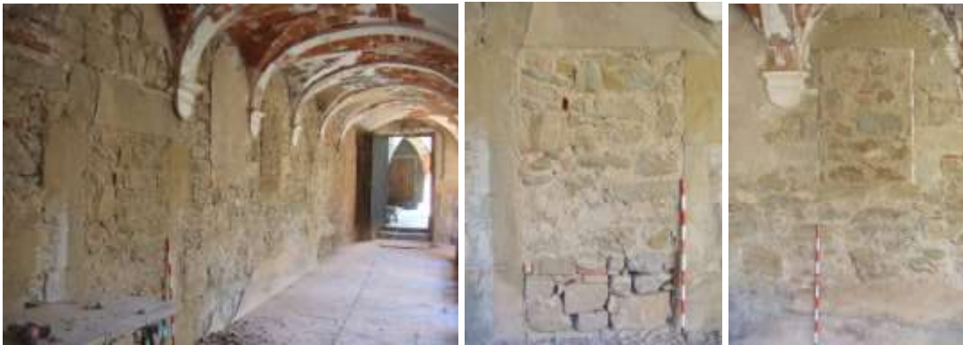
Vista general de la galeria sud del claustre i detalls de la porta i finestra paredades. Fotos. P. Cascante 2016.
