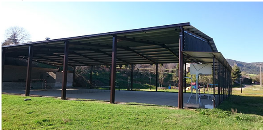
Pista esportiva coberta
