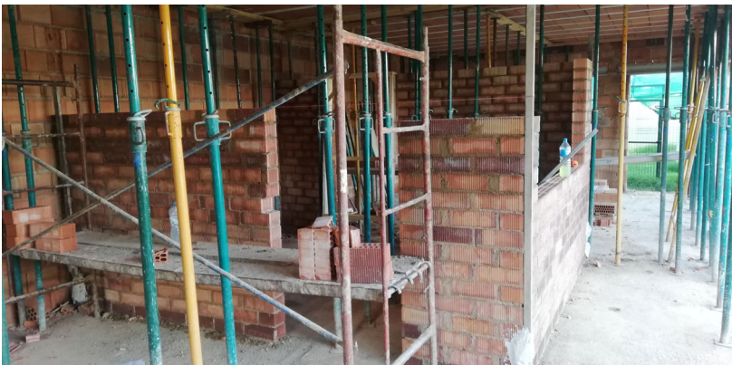
Aixecament tancaments cuina edifici barra 1, 1ª FASE
