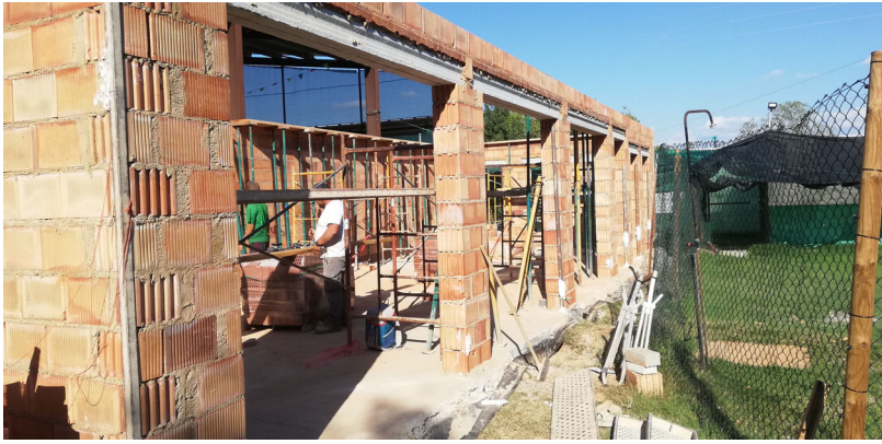
Aixecament estructura edifici barra 1, 1ª FASE
