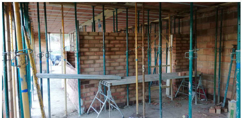
Aixecament tancaments cuina edifici barra 1, 1ª FASE
