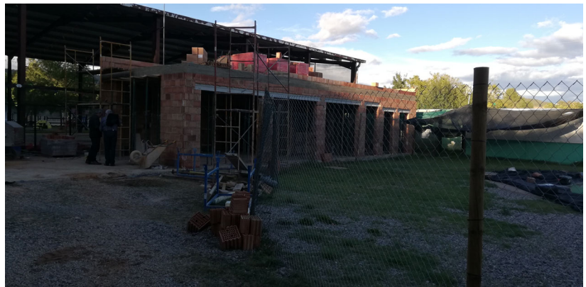
Aixecament forjat-terraça edifici barra 1, 1ª FASE
