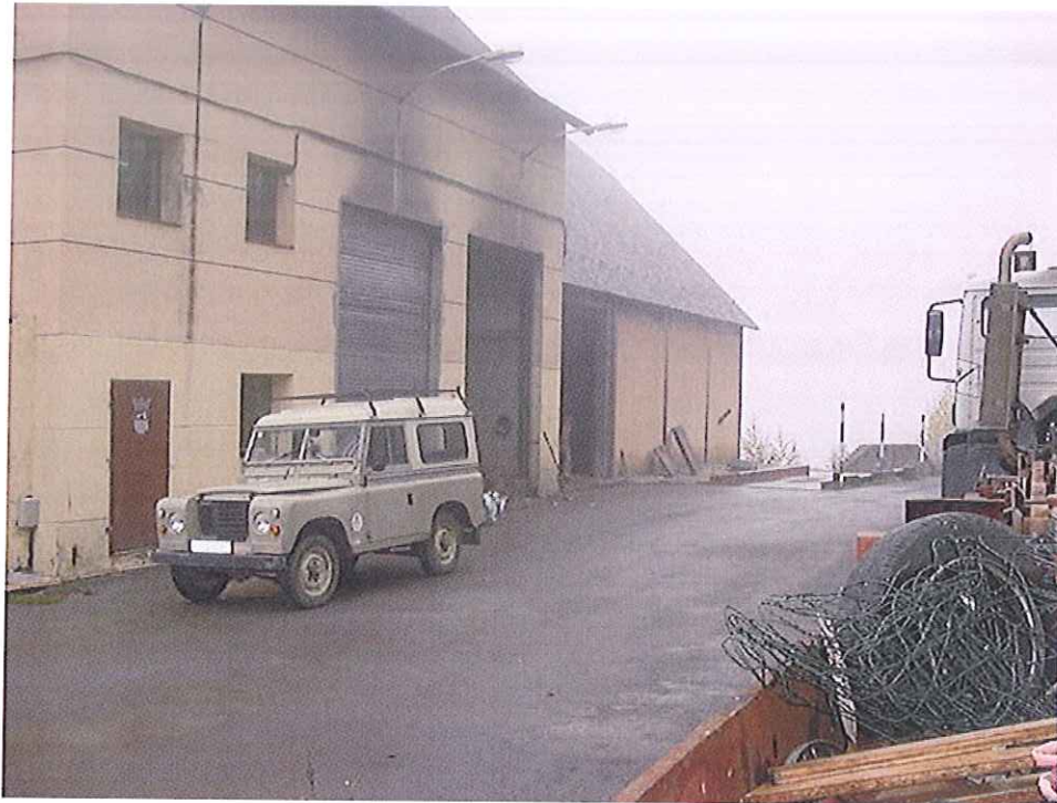
Figura 5 Vista posterior dels edificis existents
