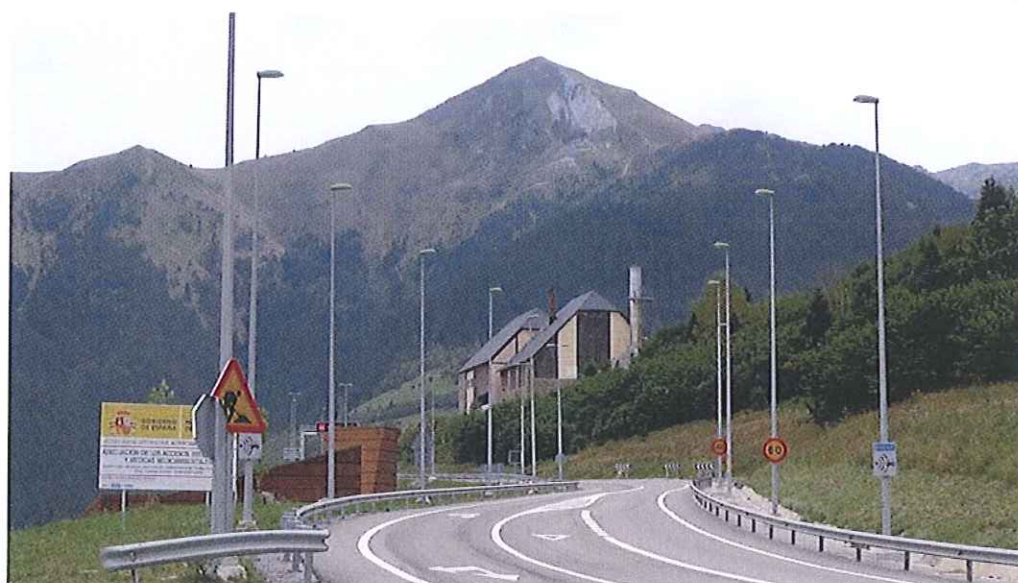
Figura 4 Vista zona ampliació edificis
