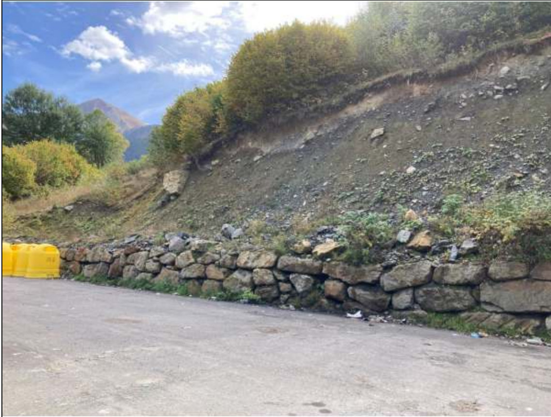
Talús Sud-01. Detall del talús Sud, davant de la Nau 4
