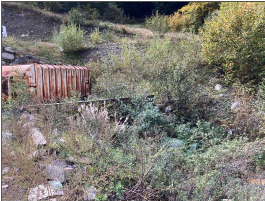
Zona Oest-03. Zona d'adequació. Cota inferior. Zona Dipòsit Lixiviats
