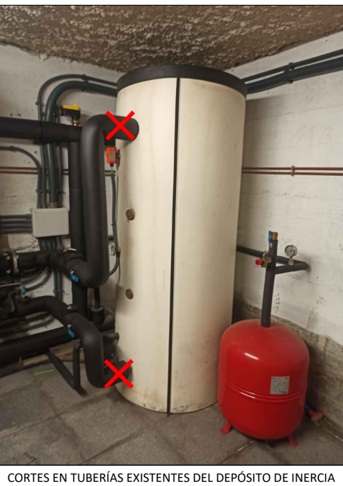
CORTES EN TUBERÍAS EXISTENTES DEL DEPÓSITO DE INERCIA
