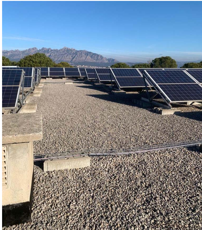
Figura 2.- Vista coberta principal de l' edifici de bombament (Objecte d'actuació)
