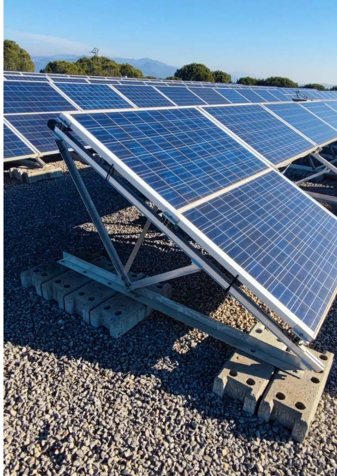
Figura 5.- Detall d'estructura i llast existent.
