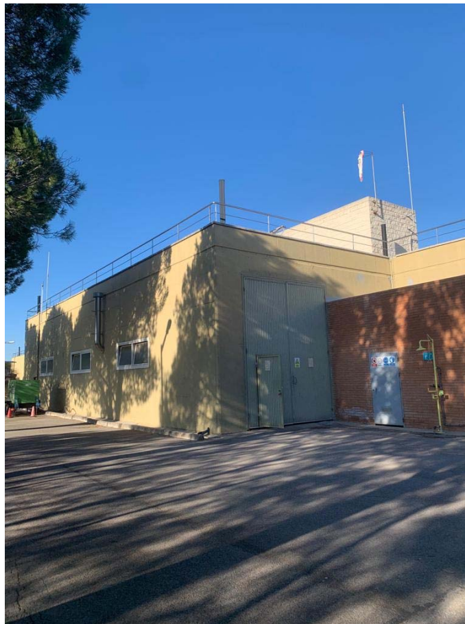
Figura 1.- Vista exterior de l'edifici de bombament Masquefa. Situació CGBT (Objecte de l'actuació)
