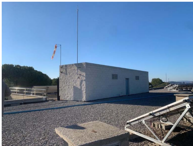
Figura 3.- Vista exterior cassetó dipòsit (Objecte d'actuació)
