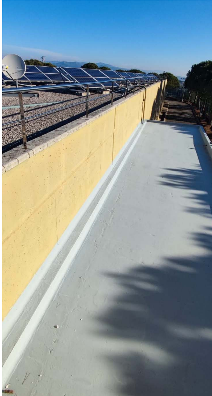
Figura 4.- Vista cassetó sala de clor (Objecte d'actuació)
