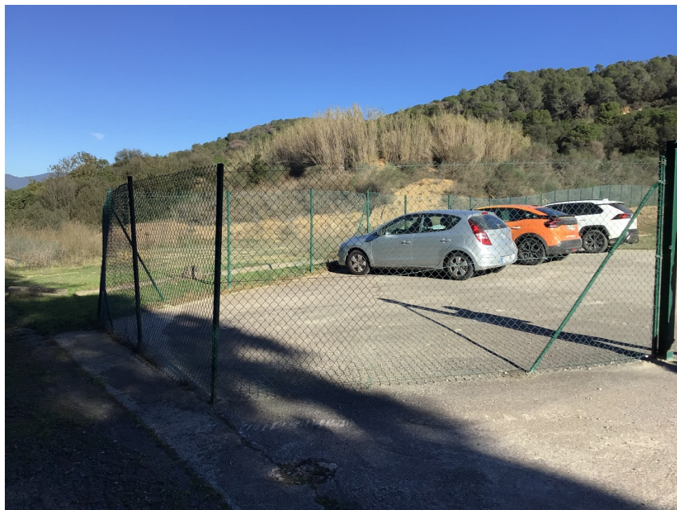
Fotografia 6 – Ubicació Centre de Transformació i Mesura
