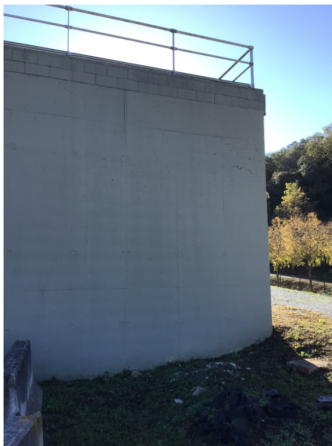
Fotografia 4 – Baixada cablejat i barana perimetral present a tota la coberta del dipòsit
