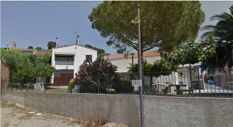
Façana principal de cant Batllori i de la Plaça annexa
