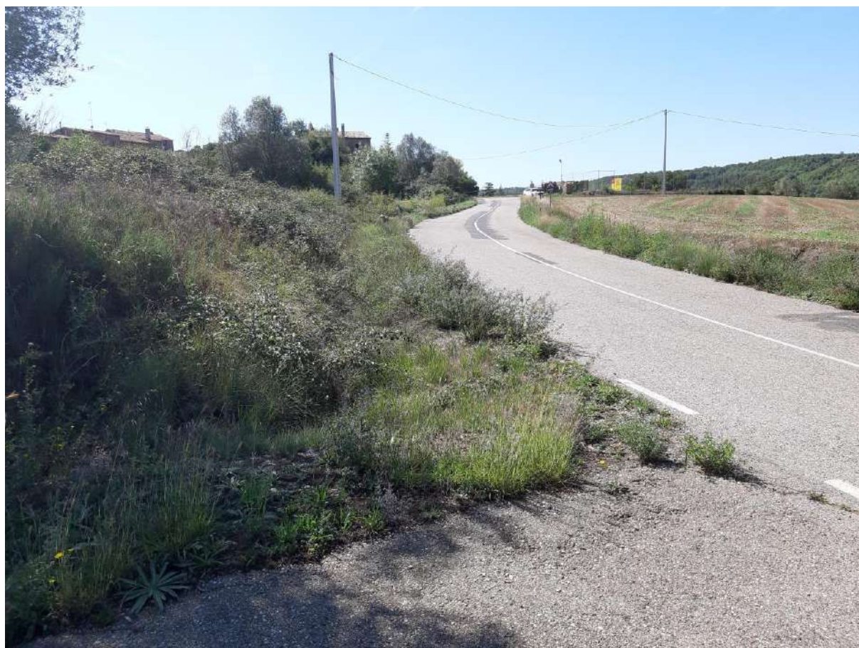
Tram final (costat accés cementiri)
