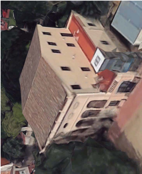
Els mòduls s'instal·laran amb la mateixa inclinació de la coberta orientació sud.
