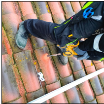
AFORADAMENT DE TEULES PER A INTRODUCCIÓ DE TAC QUÍMIC
