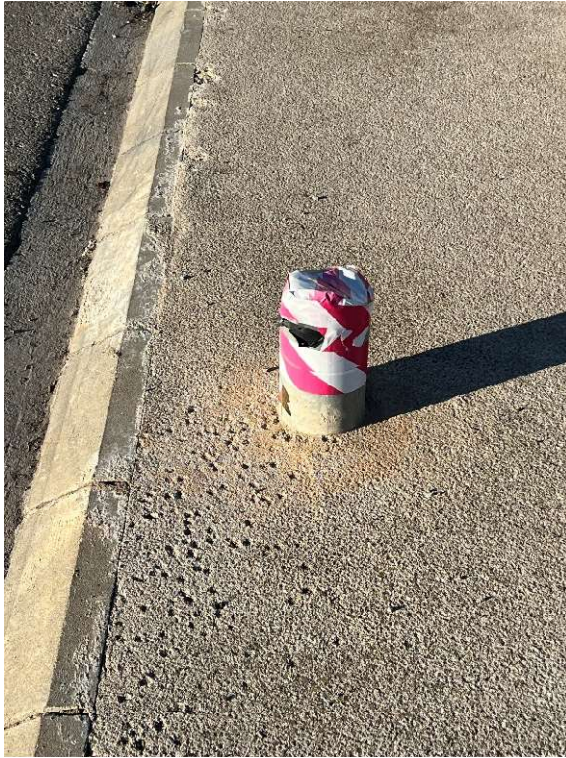
Fotografia 7. Columna cortada
