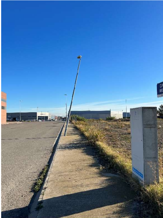
Fotografia 5. Columna torcida por un golpe (2)
