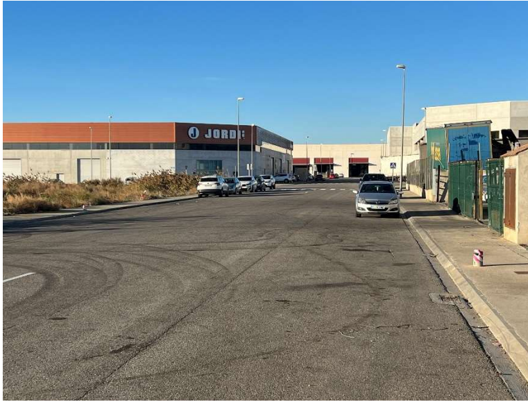
Fotografía 1. Alumbrado calle tipo a reformar
