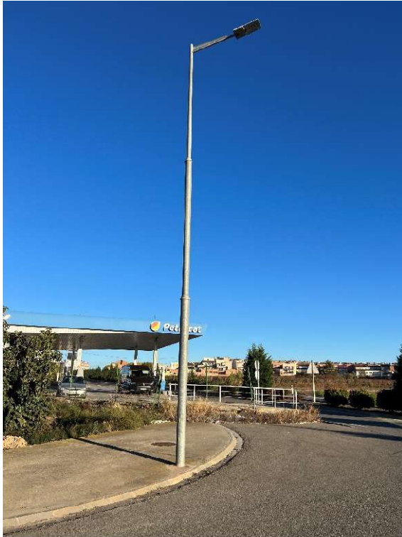
Fotografía 9. Columna telecopia de tres tramos de 12 metros de altura torcida a sustituir
