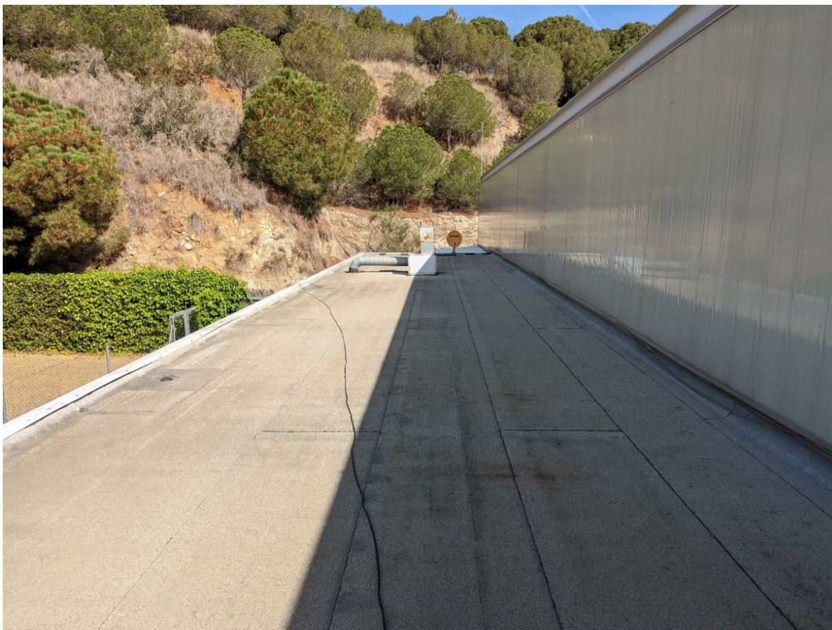
COBERTA ZONA BAR – VISTA NORD
