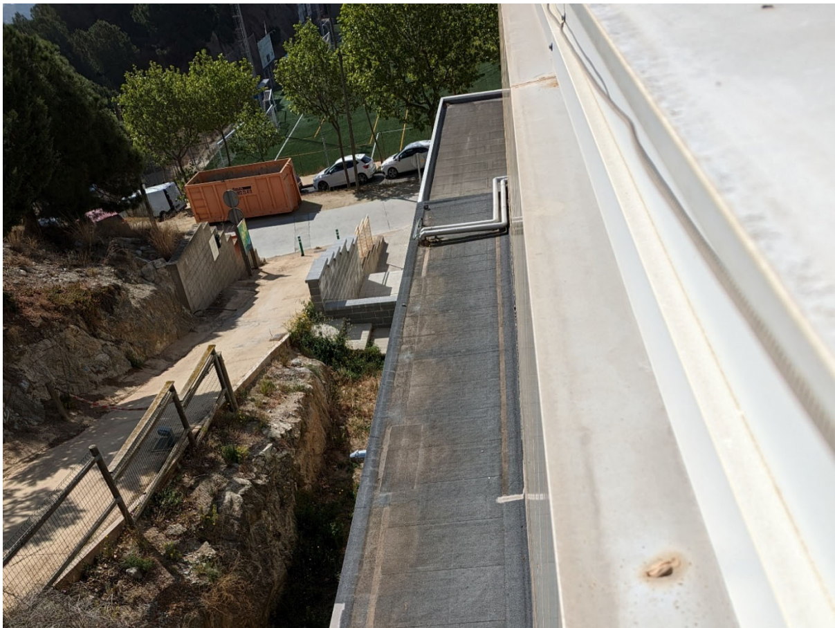
COBERTA SORTIDA EMERGENCIA - VISTA SUD
