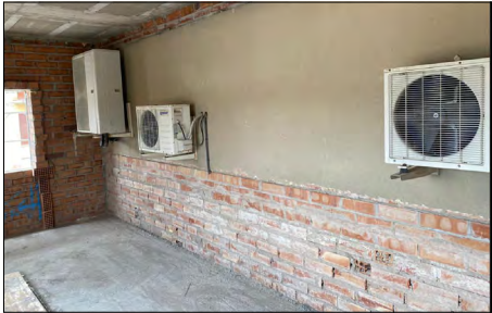
DESMONTATGE DE MÀQUINES
