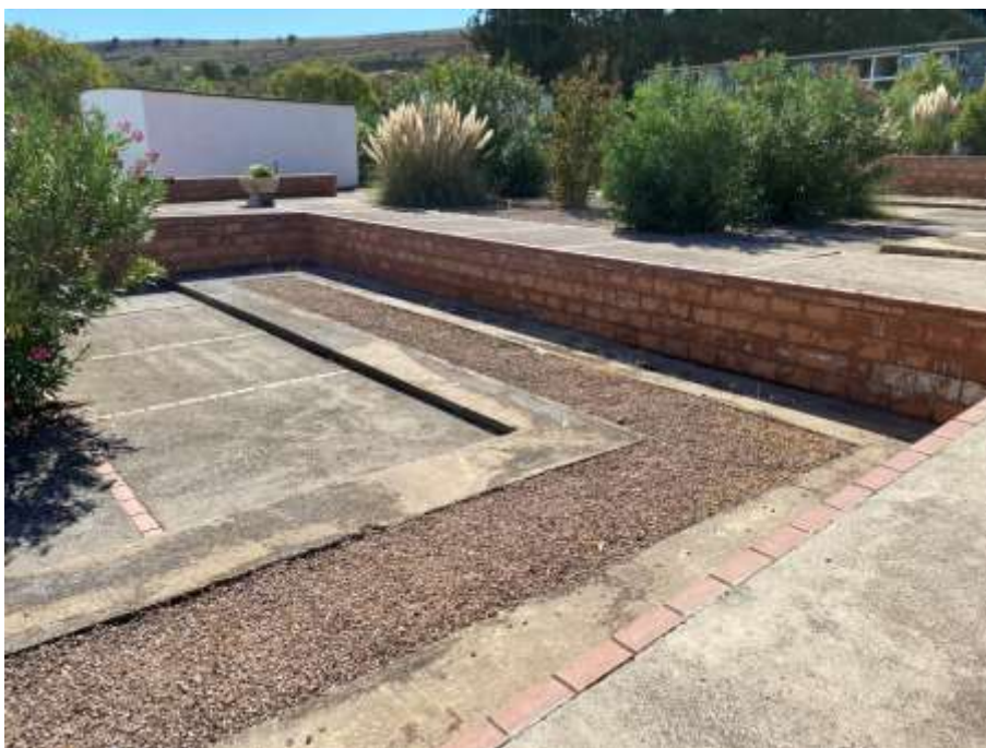
Vista general de la zona
