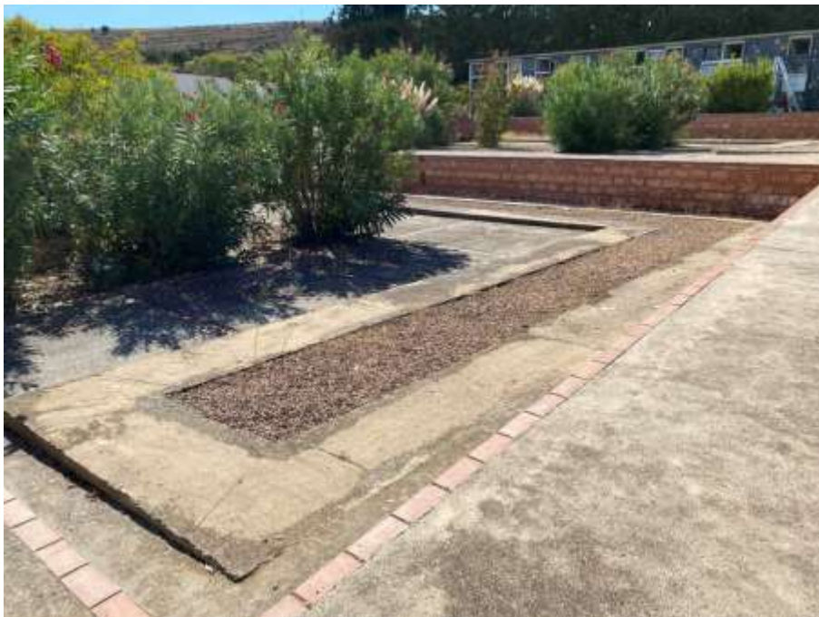
Vista general de la zona
