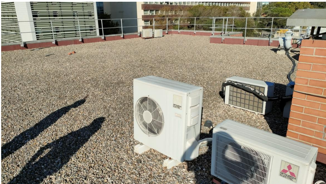
Espai en planta coberta per col·locar la unitat exterior
