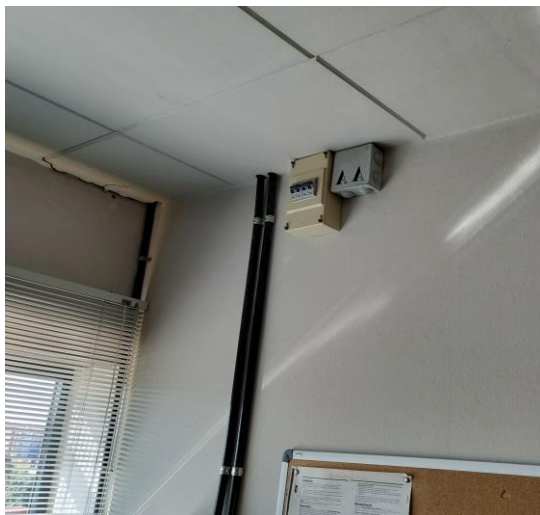
Proteccions actuals dels equips de climatització.
