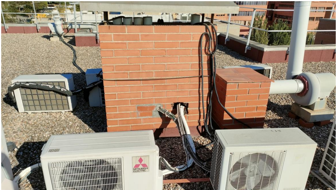
Badalot d'obra per on sortiran els tubs frigorífics cap a la coberta
